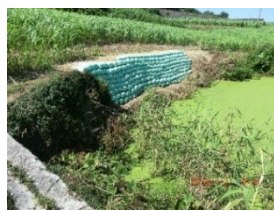
堆置砂袋 防止崩塌擴大
