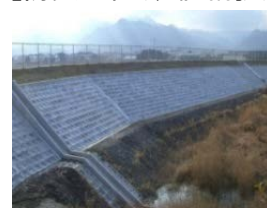
【防災工程（堤體補強）】
