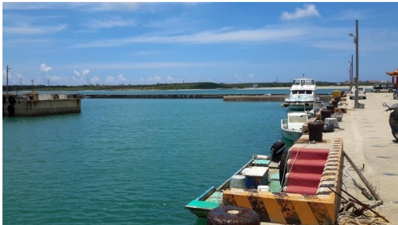
圖 86. 白坑漁港現場照片
