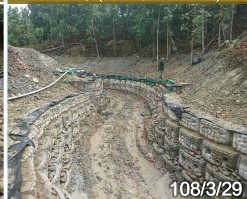
施工中(採用預鑄工法)
