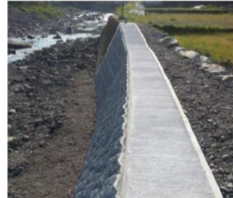
使用掃帚掃過未乾堤頂混凝土表面的質感
