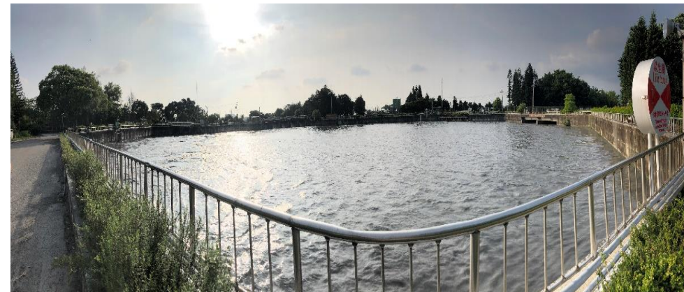
八卦分水池全景
