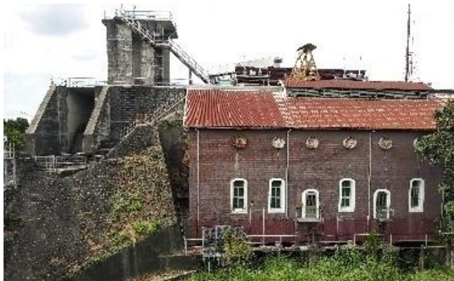
濁水發電所外部環境
