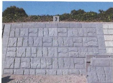
預鑄混凝土塊護岸鋪設 (正面)
