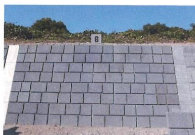
預鑄混凝土塊護岸鋪設 (正面) 改良後
