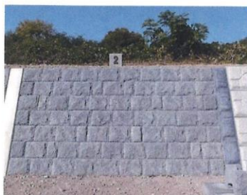
預鑄混凝土塊護岸鋪設（正面）改良後
