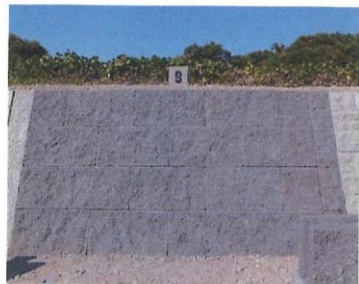
預鑄混凝土塊護岸鋪設 (正面)
