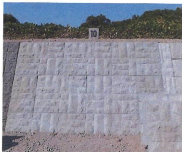
預鑄混凝土塊護岸鋪設 (正面)
