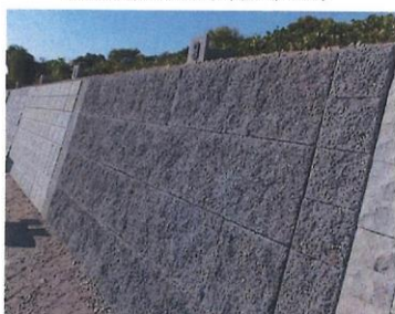
護岸端牆 (牆) 預鑄混凝土塊
