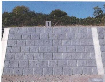
預鑄混凝土塊護岸鋪設（正面）改良前
