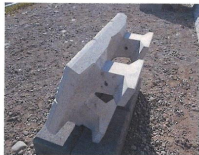
預留空間的護岸頂端支撐架構
