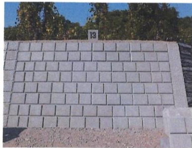
預鑄混凝土塊護岸鋪設 (正面)
