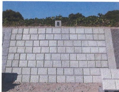
預鑄混凝土塊護岸鋪設 (正面)
