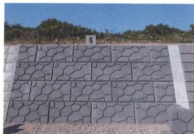
預鑄混凝土塊護岸鋪設 (正面) 改良前
