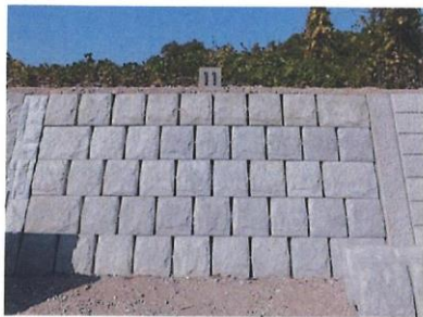
預鑄混凝土塊護岸鋪設（正面）
