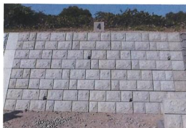
預鑄混凝土塊護岸鋪設（正面）改良後
