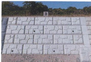
預鑄混凝土塊護岸鋪設（正面）改良前
