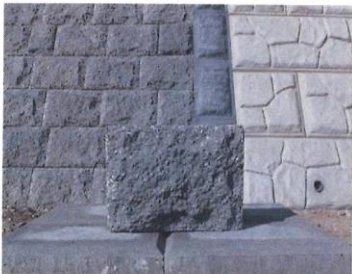
預鑄混凝土塊護岸單體（正面）改良後
