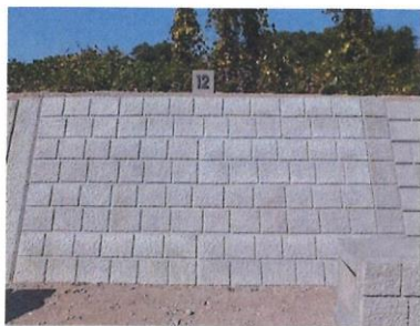
預鑄混凝土塊護岸鋪設 (正面)
