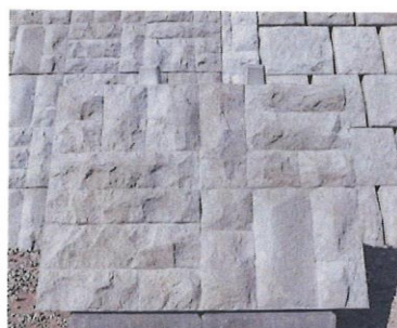
預鑄混凝土塊護岸單體 (正面)
