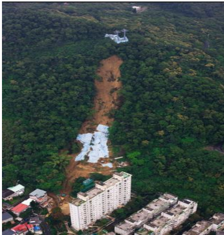
降雨導致邊坡崩塌
