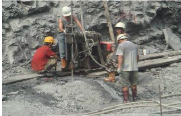
基礎灌漿錨筋
