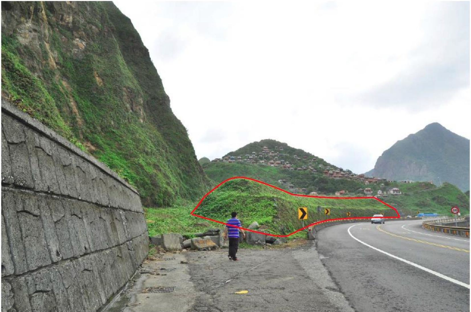
加勁結構物應用於防落石擋牆 (台灣北海岸道路)
