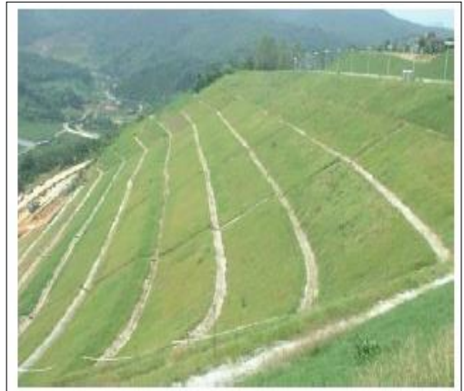
以地工合成材加勁工法修復崩塌之道路邊坡
