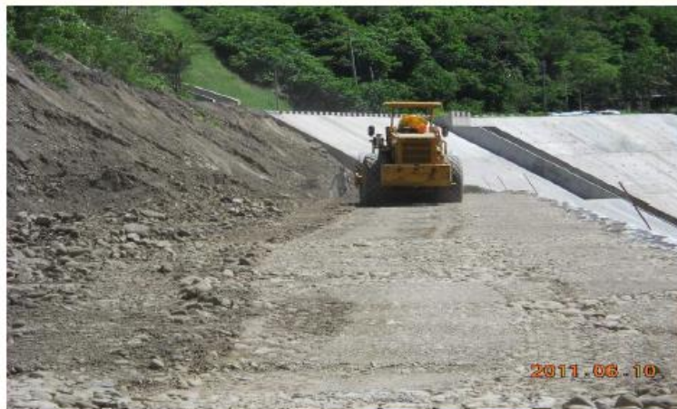
土方輾壓施作
