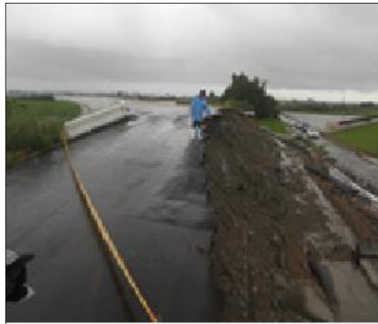
堤防受洪水與滲流破壞
