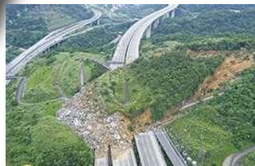
坡地災害(99年國道三走山)
