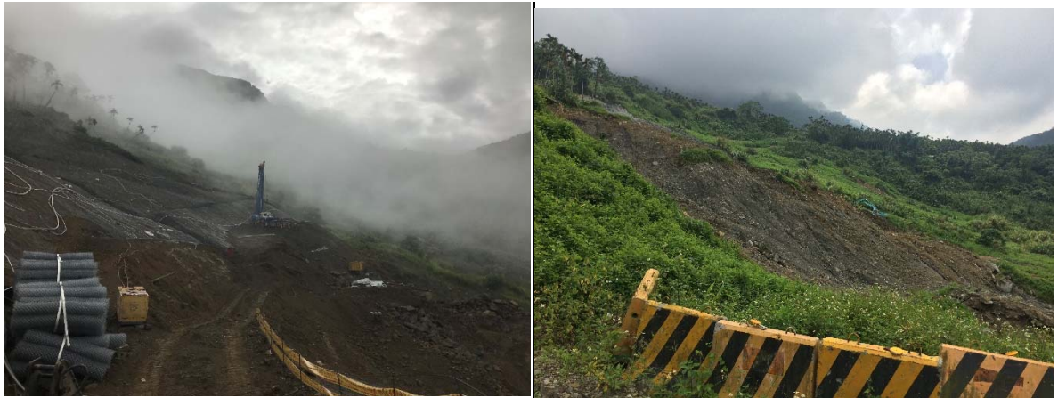
圖 3.35 五彎仔地區 N4 地滑區東邊邊緣表面噴混擬土工程（2017/12/8 與 2018/9/14 拍攝）
