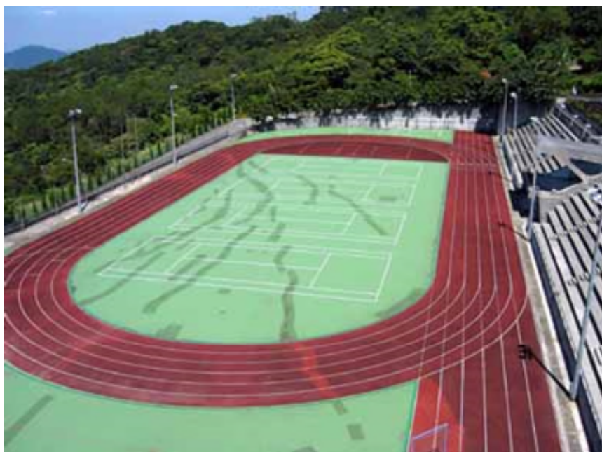
圖 2-11 華梵大學校園西部可能的滑動塊體之地表破裂
