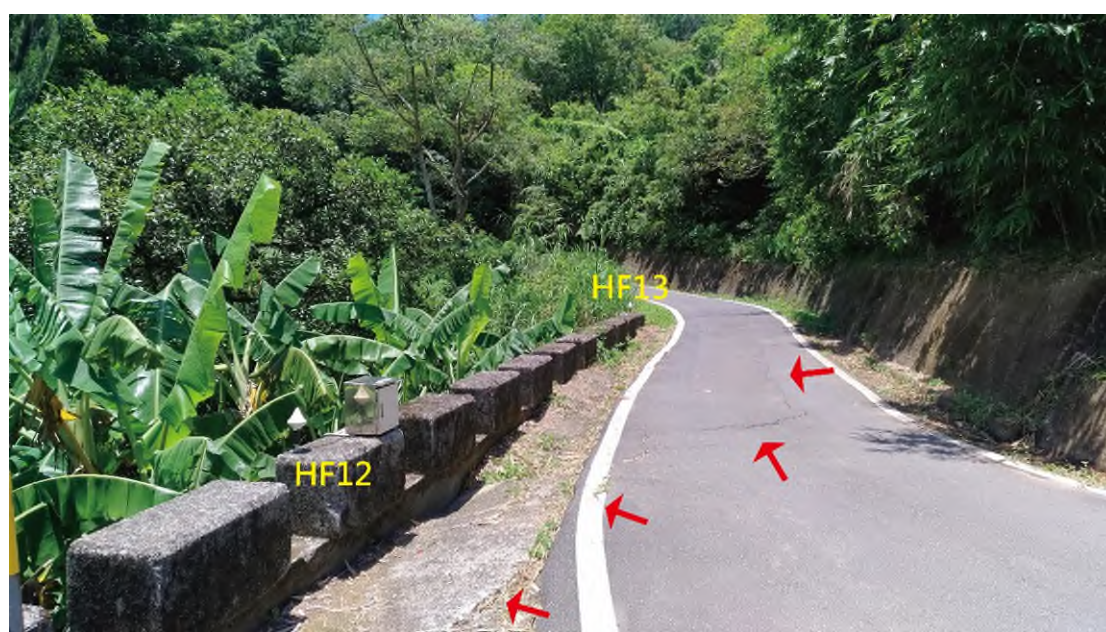
圖 3-5 單頻 HF12 處之淺層破壞
