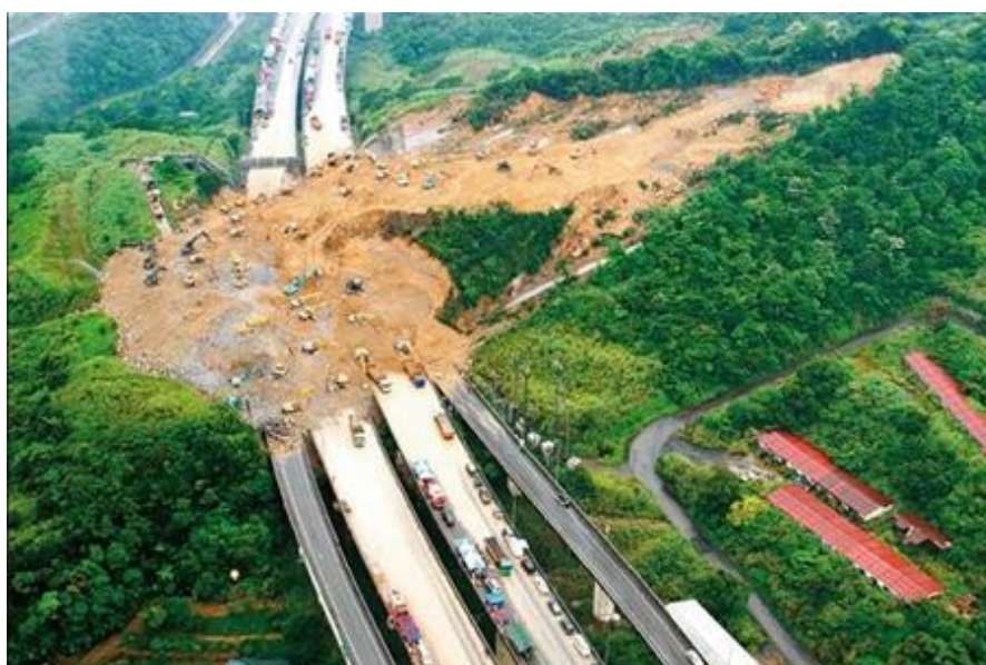
圖 1-2 國道三號崩塌圖
