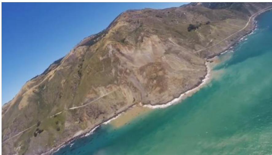
圖 1-1 加州一號公路崩塌照
