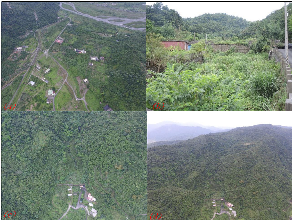
圖 5-12 宜縣 DF119、120 現勘照片
