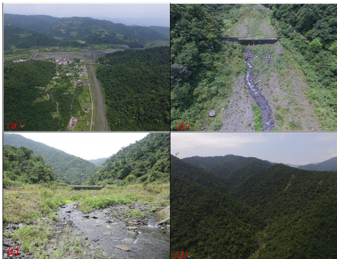
圖 5-6 宜縣 DF085 現勘照片(2019/06/12)
