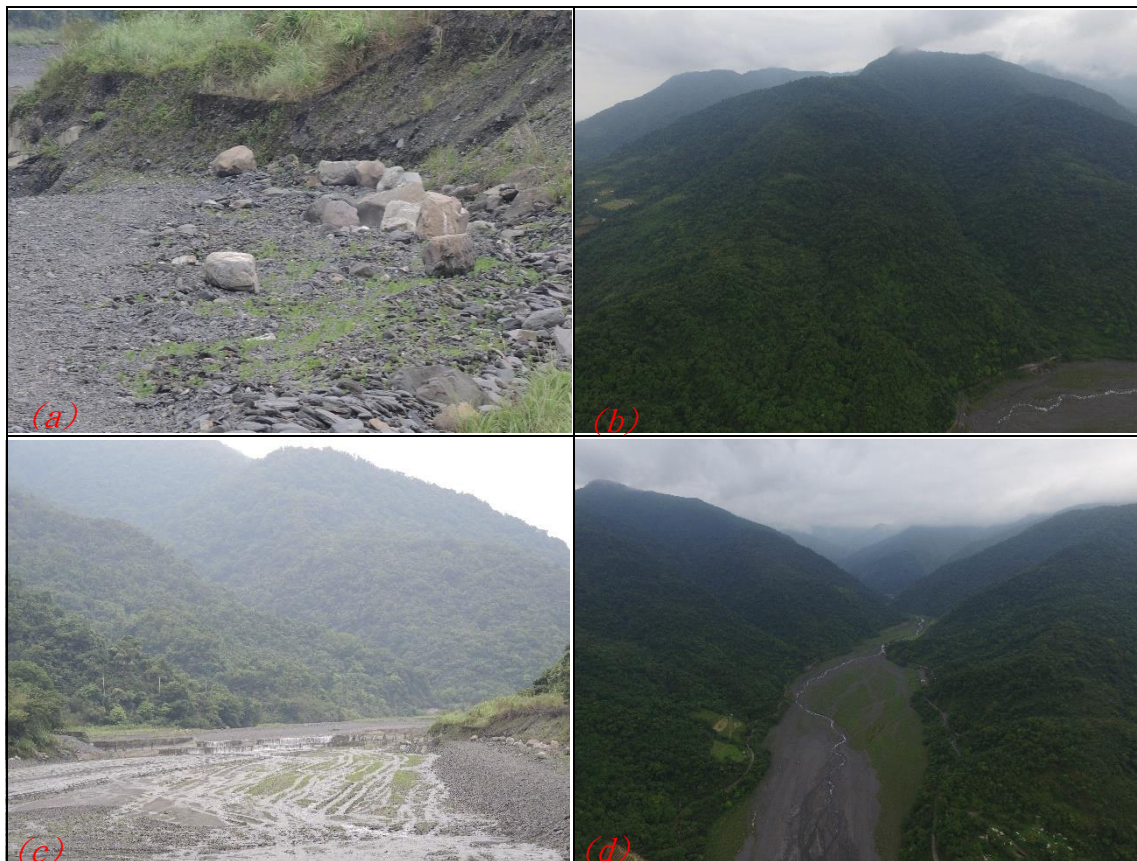
圖 5-4 宜縣 DF060 現勘照片(2019/06/11)
