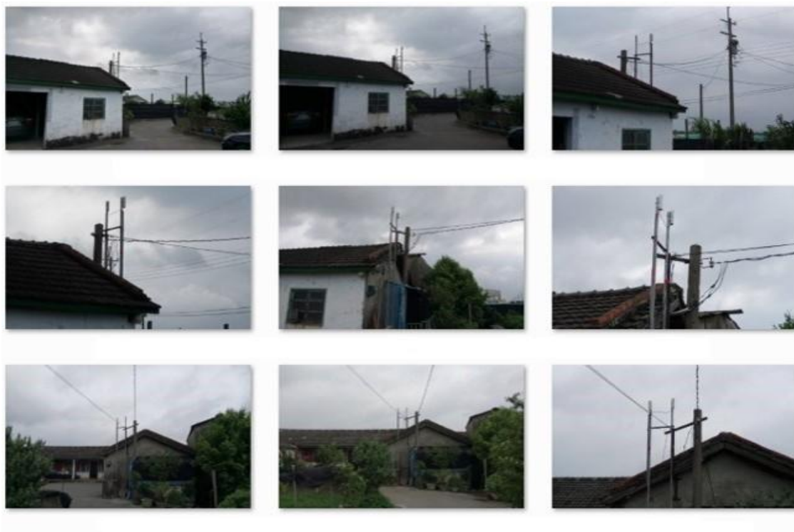
圖 3-1-8 無線網路基地台 AP3 及 AP4 立桿架設作業
