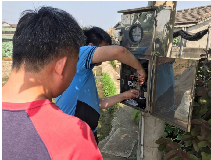
圖 3-3-8 自動灌溉裝置安裝過程
