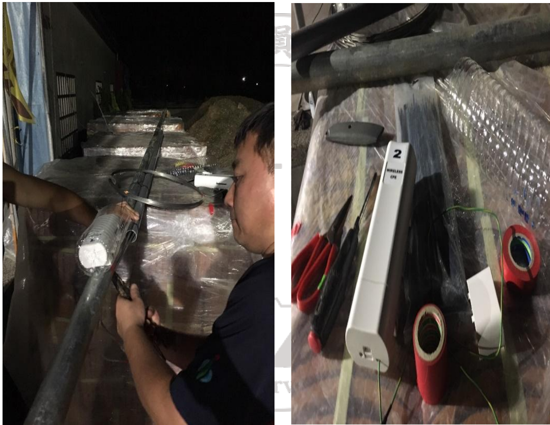
圖 3-1-6 無線網路設備與架設前置配線固定過程
