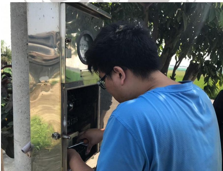
圖 3-3-9 自動灌溉裝置安裝過程
