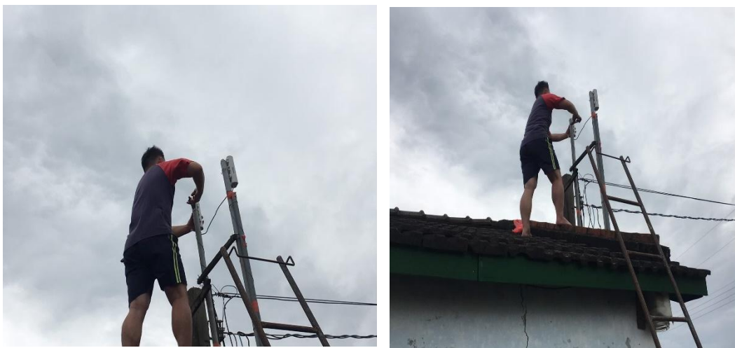
圖 3-1-11 利用空閒時間進行全區無線網路訊號量測作業
