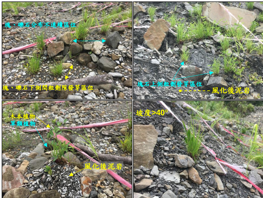
圖 7-4 陡坡崩塌地建構微植生基盤之現地驗證(一個月後)
