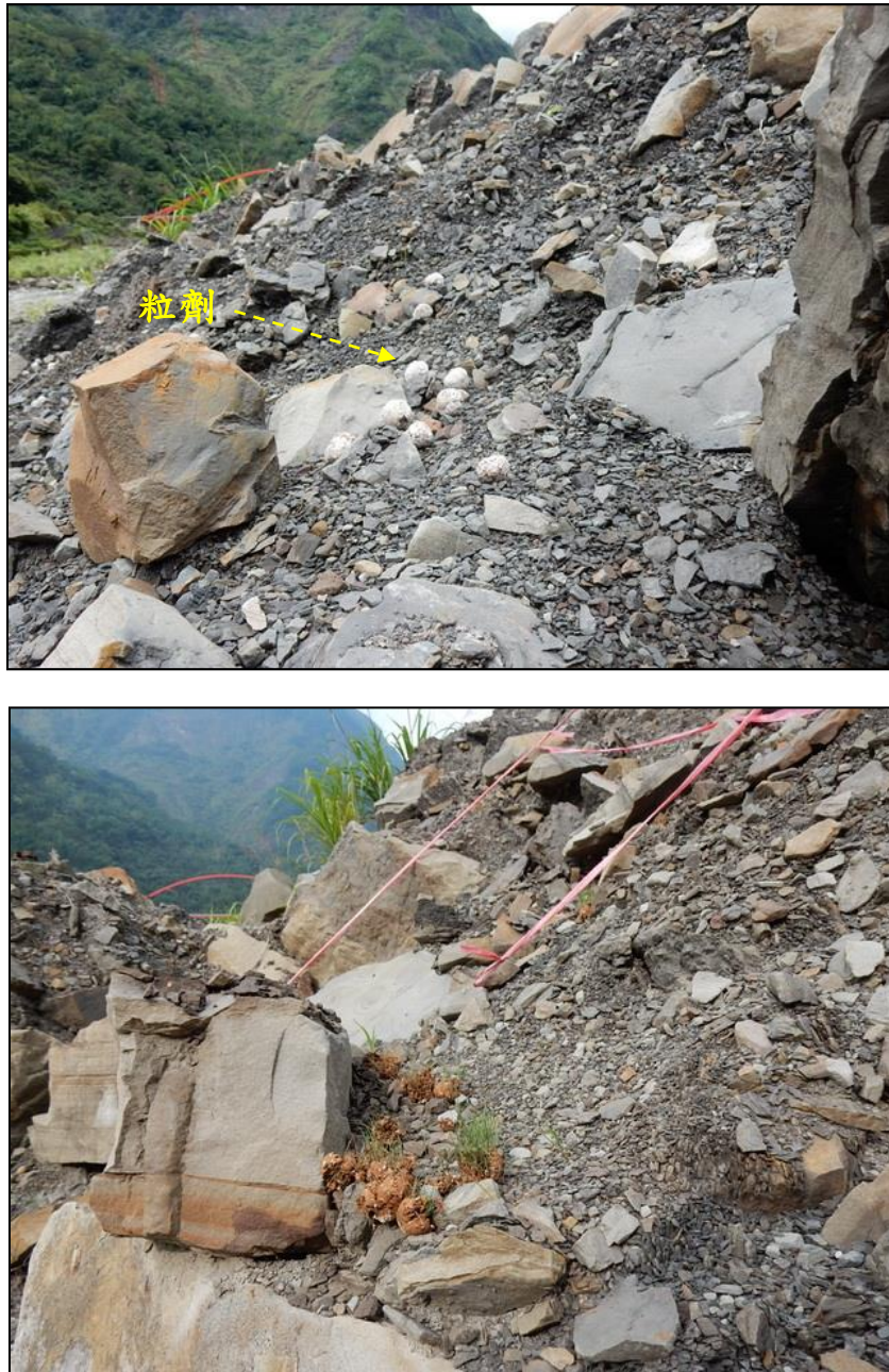
圖 5-2 植生粒劑定著崩塌地坡面初期與其發芽之情形
