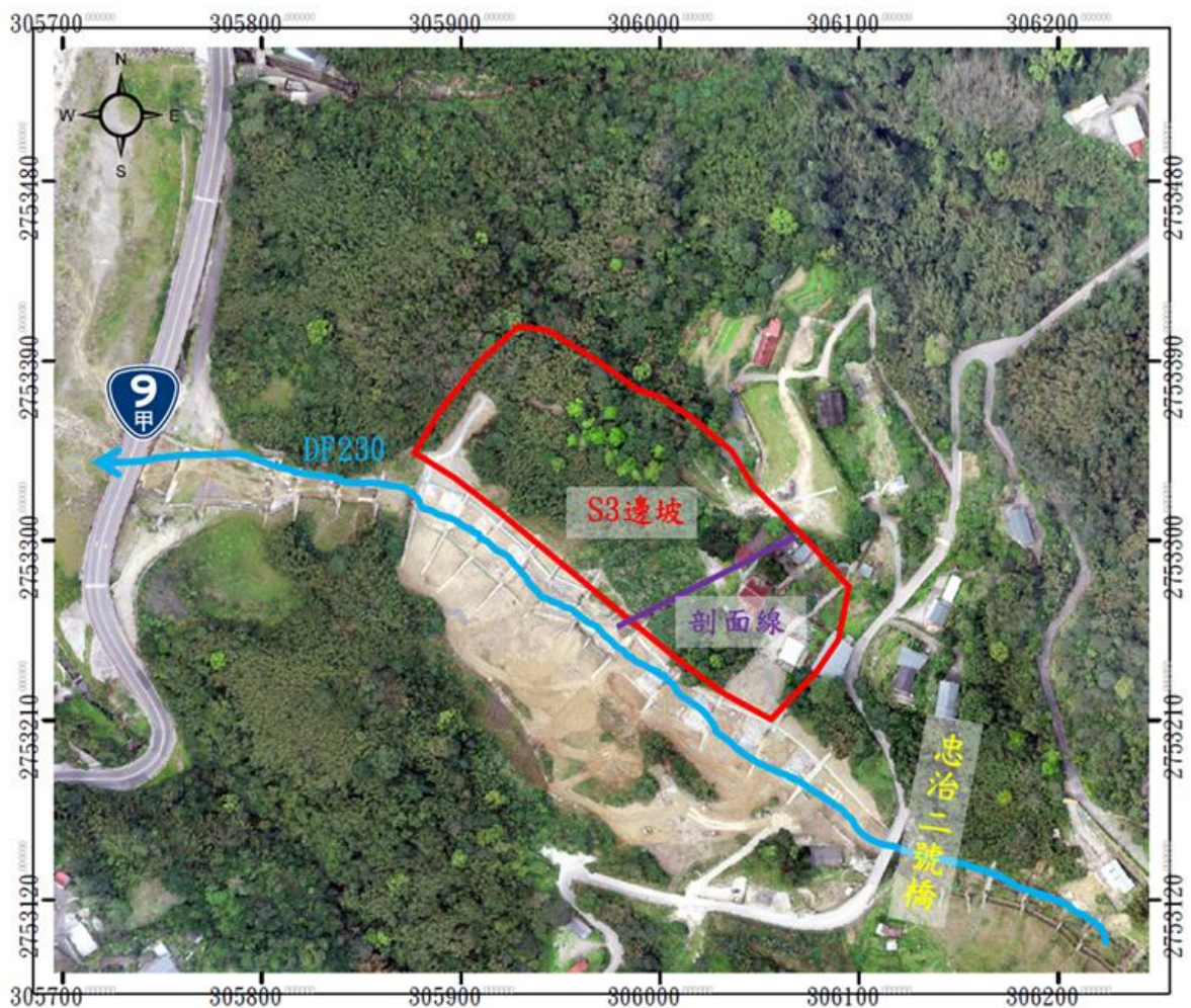
圖 2-58 忠治二號橋下游右岸 S3 邊坡
