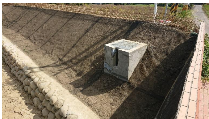
圖 4-37 路側溝集水進入農塘
