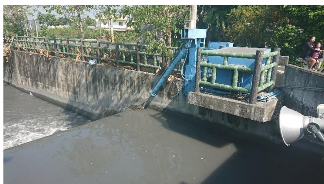
圖 4-49 電動倒伏堰
