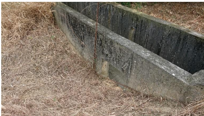
圖 4-6 農塘入流側流堰
