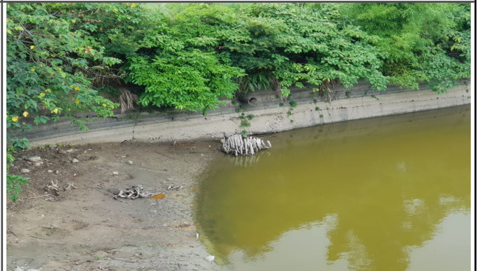
進水口(RC管)
