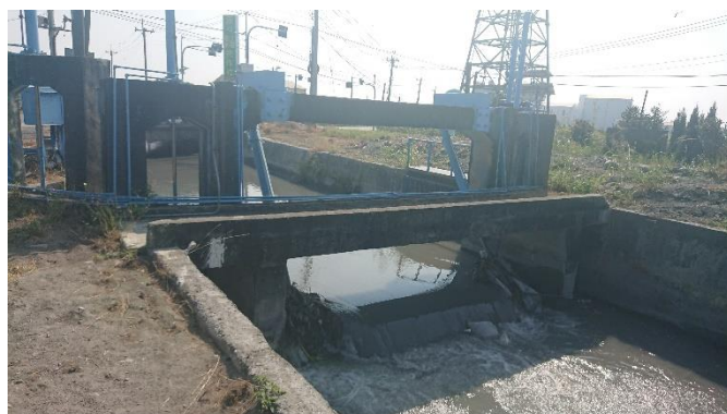
圖 4-51 第九制水門電動倒伏堰下游
