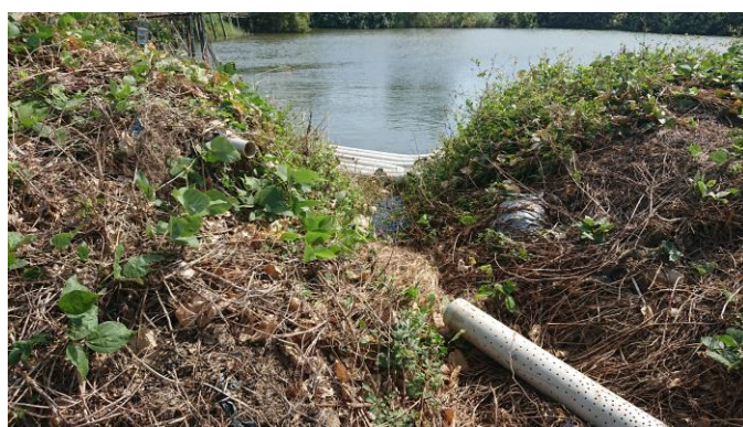
圖 4-32 農塘較低岸自由溢流
