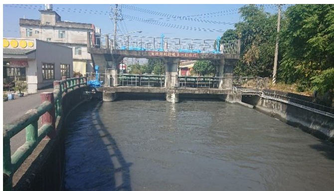
圖 4-40 荖仔埤第一制水門
