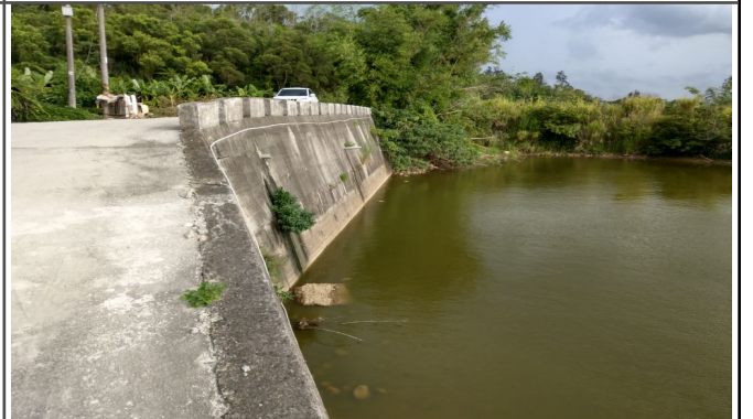
進水口(PVC管)
