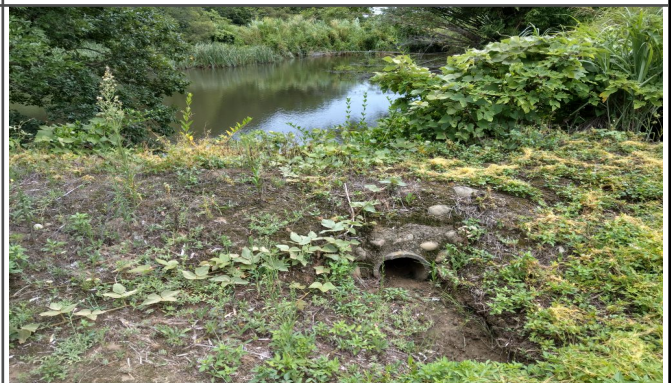
進水口(RC管)
