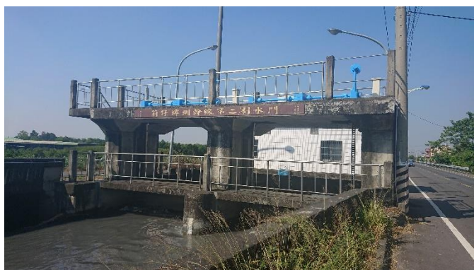
圖 4-44 荖仔埤第二制水門
