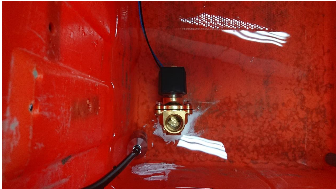
圖 2-9 農塘之常閉電磁閥
