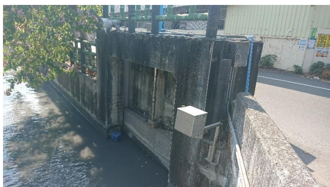
圖 4-48 電動油壓式閘門
