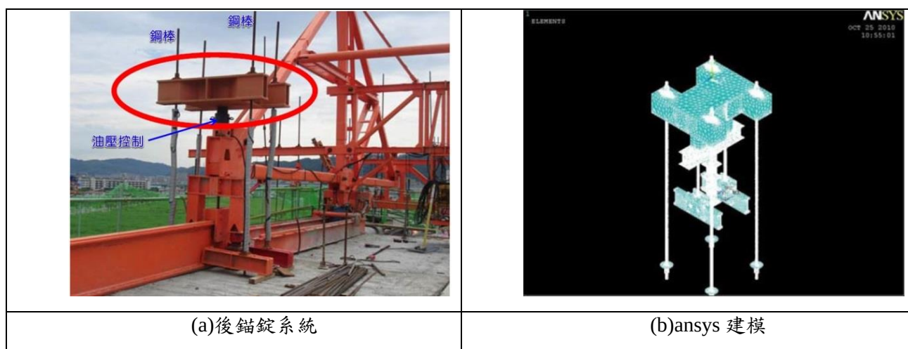
附圖 1-1 後錨錠系統 ansys 建模
