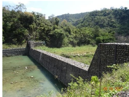
圖 2-6 里仁溪二期工程
