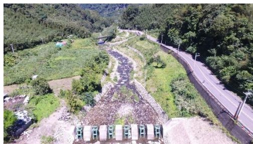
圖 2-7 煤源二號橋二期治理工程
