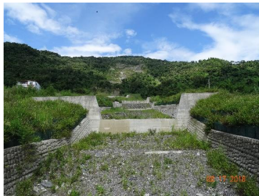
圖 2-5 紅葉紅谷橋野溪復建工程
