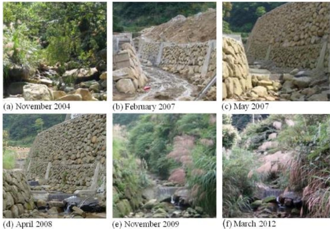
圖 2-4 護岸施工前後的圖像 (a) 原始狀態 (b) 建築狀態 (c) 早期完工狀態 (d-f) 植被恢復狀態(Chen and Ho, 2013)
