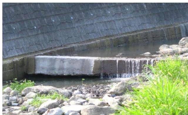
圖 2-1 設施產生淘空破壞形態
