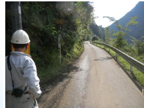
写真-5. 2. 32 県道に新たな亀裂や段差などの地すべり変状ない
