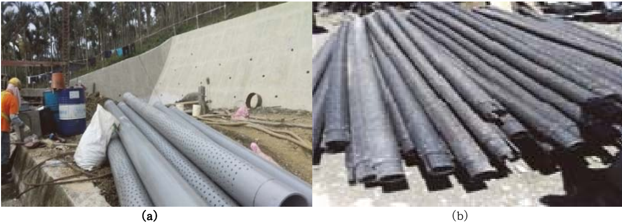
圖 4-5 橫向集水管 (a) 聚氯乙烯 (PVC) (b) 高密度聚乙烯 (HDPE)
