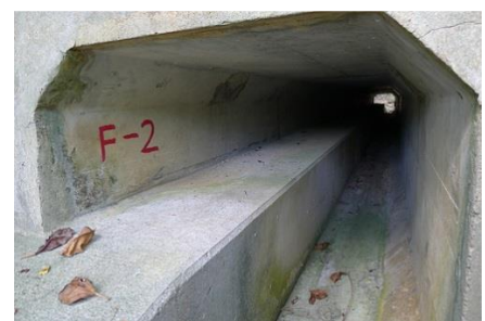
地下涵洞型的動物通道 (underpass)
