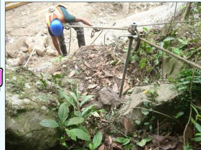
以雙掛勾方式進行邊坡作業
