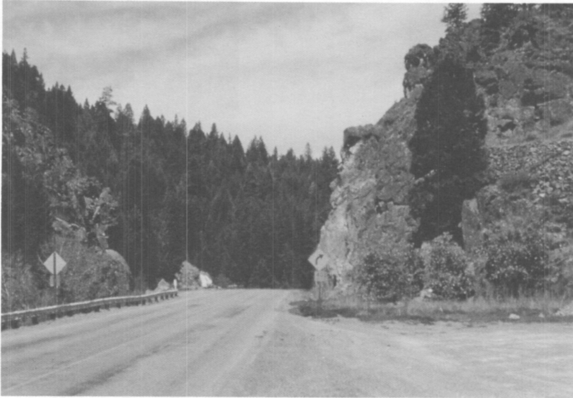
圖 5.1：落石是由高速公路上方的天然邊坡破壞所造成
