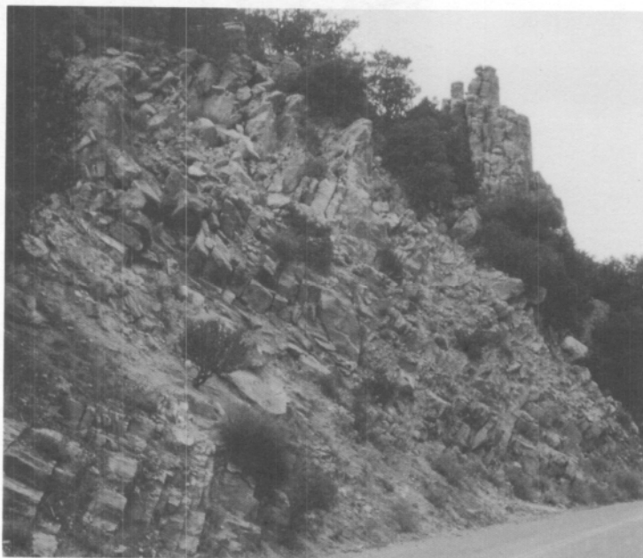
圖 5.3：判定邊坡的垂直高度而非斜面長度，73 呎高的邊坡得分為 25。
