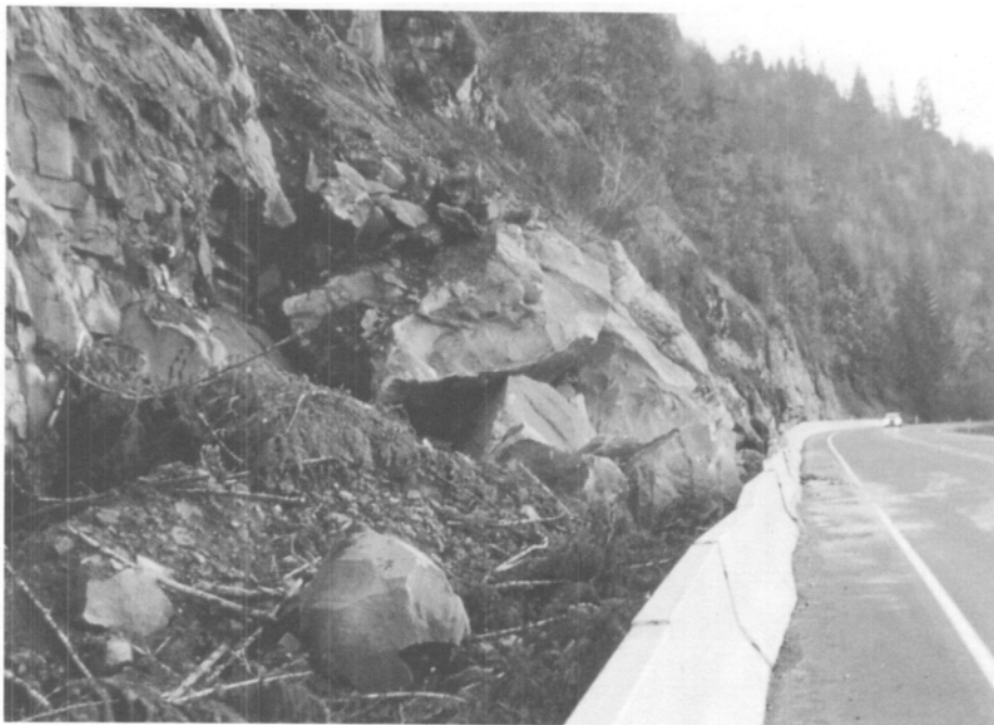
圖 8.2：當大塊落石落下時，碎片會掉落到道路上，未來的落石尺寸將會更小並落在排水溝中。
