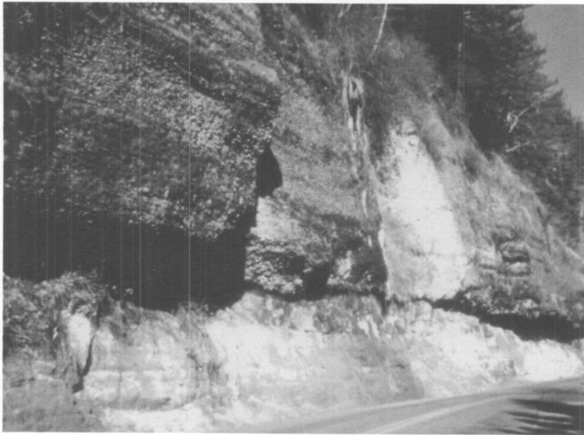
圖 3.4：差異性沖蝕造成的懸垂邊坡
