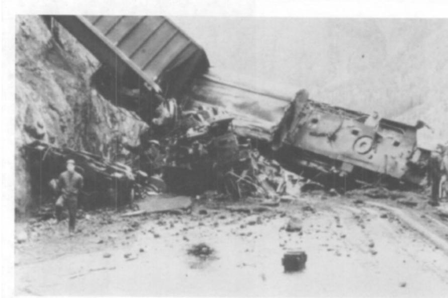
圖 1.2：落石造成的鐵路事故
