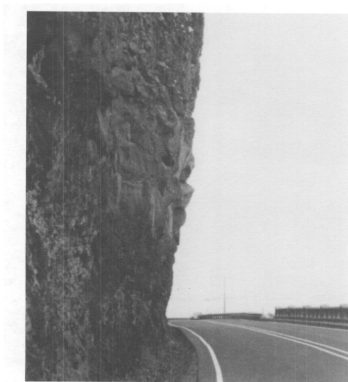
圖 5.6：此邊坡上的落石會落在道路上，排水溝無承接區。
