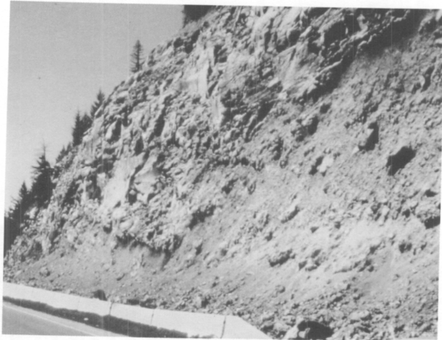
圖 5.27：邊坡底部的碎屑受到凍融循環和雨水的強烈影響，出現極端的差異。
