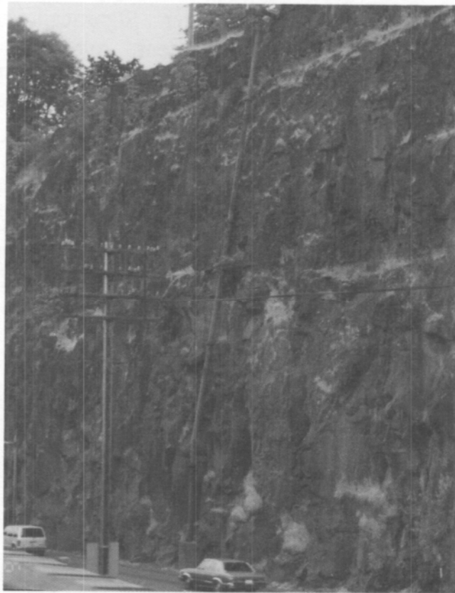
圖 5.2：當邊坡幾乎垂直並可直通頂部時，可以用量尺測量其高度。
