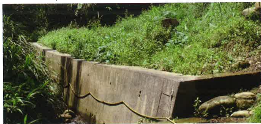
圖 3-3 溪岸逕流受混凝土構造物阻隔
