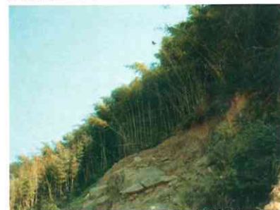
圖 5-19 桂竹林崩塌地
