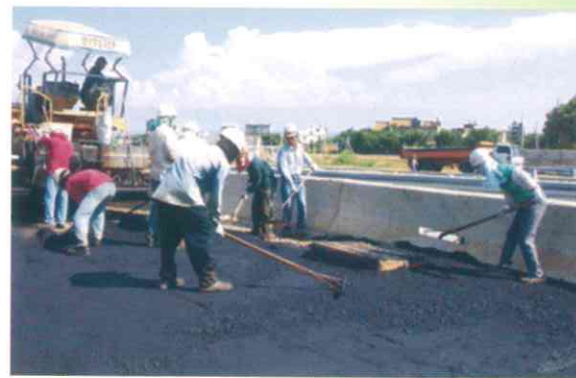
確實鋪築夯實
