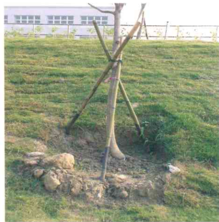
支撐不良-坡面支撐方向錯誤
