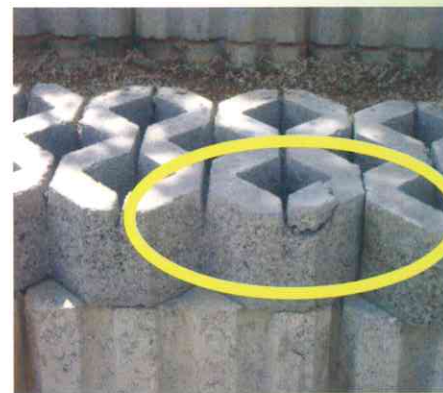
材料破裂
