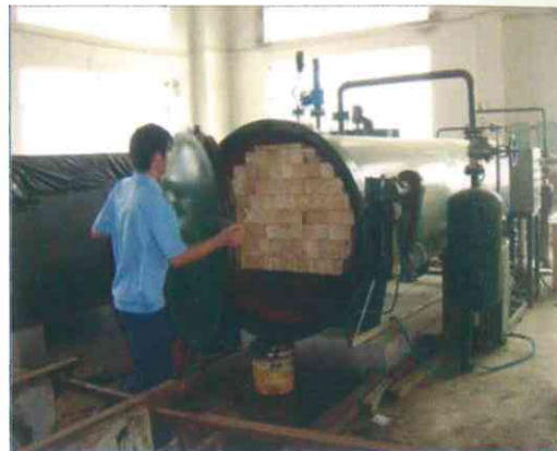
木材確實做好防腐措施
