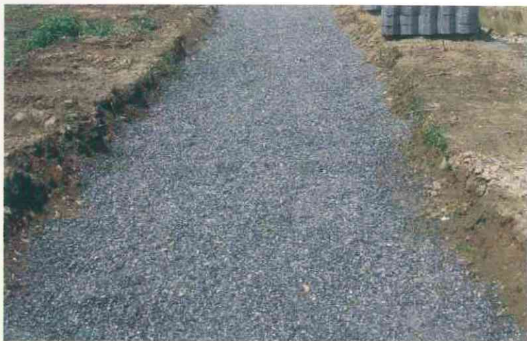
底層鋪設須符合設計圖說
