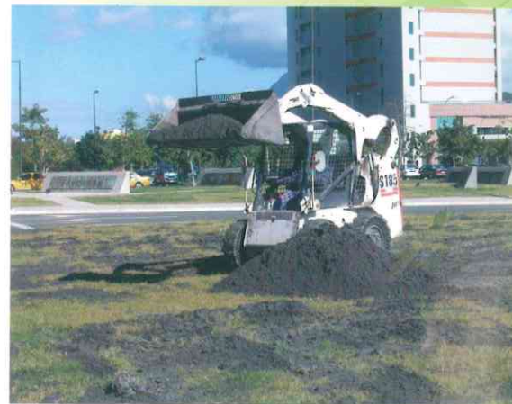
草皮鋪植後表面鋪細砂處理保護根系
