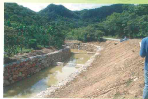
混凝土固床工
