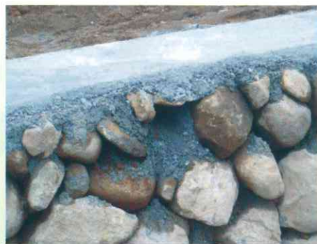
頂部不得澆置混凝土
