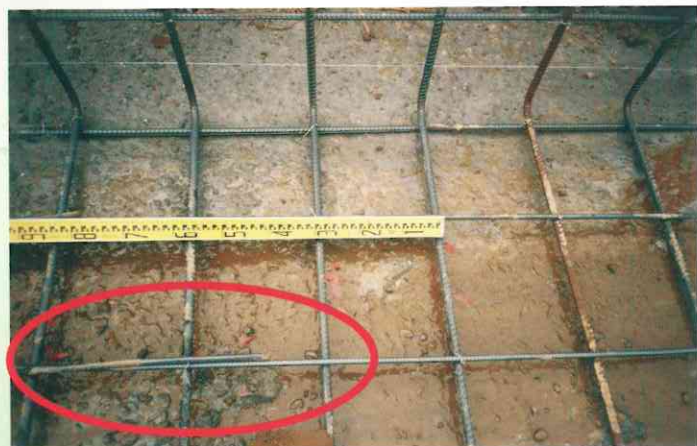
鋼筋綁紮與搭接
