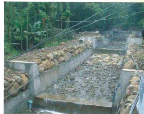
混凝土跌水工
