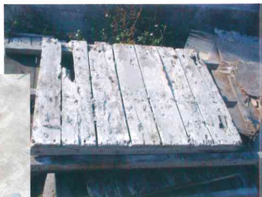
破損不堪使用
