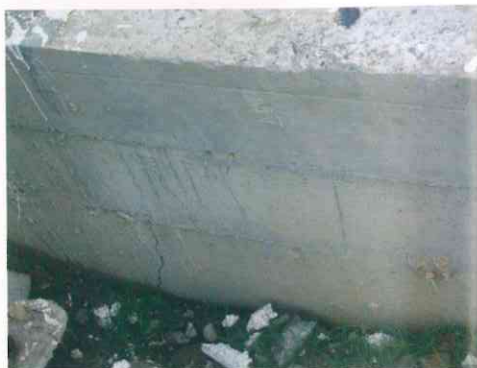
擋土牆破裂
