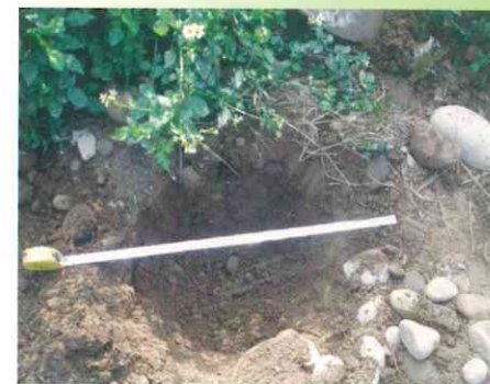
植穴寬度與深度應符合設計圖說
