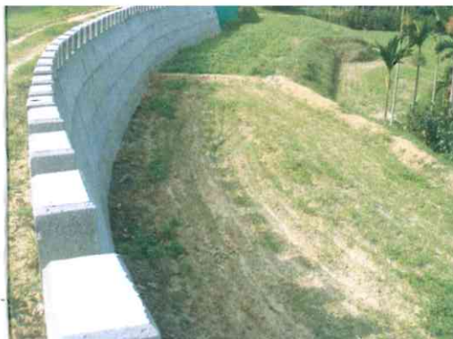
重力式擋土設施
