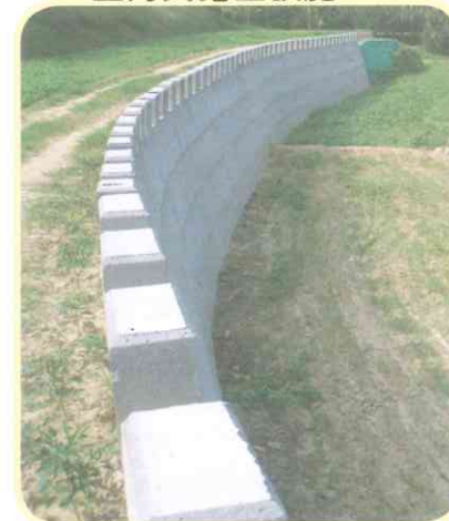
重力式擋土設施
