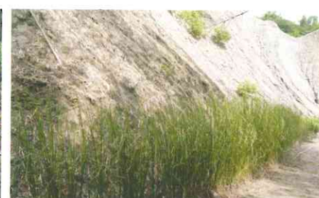
▲種植於泥岩地坡腳供為攔蓄土砂
