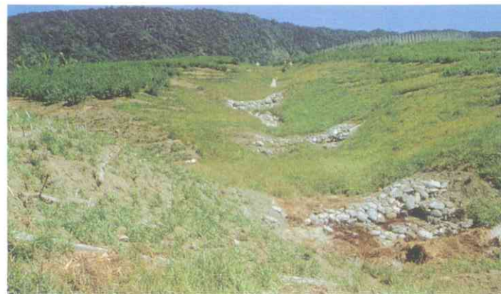
▲沖蝕控制（蝕溝控制配合百喜草栽植）
