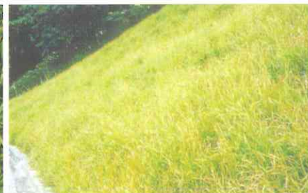
▲道路邊坡覆蓋情形
