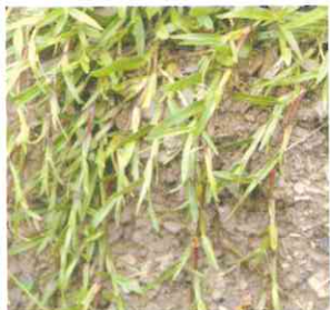
▲裸露邊坡生長情形
