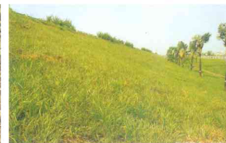
▲應用於道路邊坡情形
