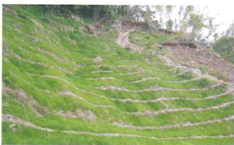
▲應用於崩塌地邊坡噴植草種
