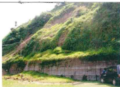
混凝土擋土牆+造形模板(月桃巷)
