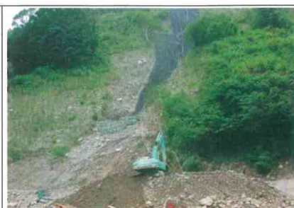
縱向排水施工
