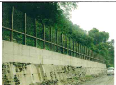
防落石柵+混凝土擋土牆(烏石坑)
