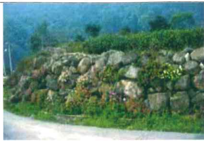
乾砌石擋土牆(中寮)
