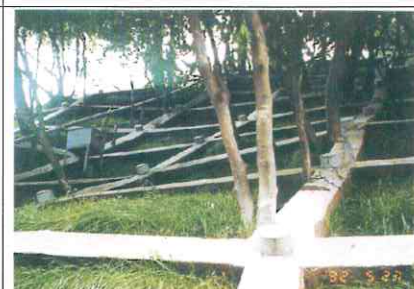
岩錨+連續混凝土固定框+厚層噴植
