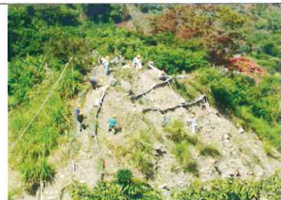
坡面整理(烏石坑)
