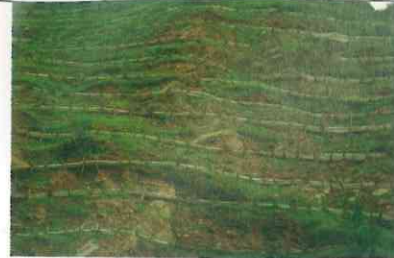
打木樁編柵(埔里鯉魚路)
