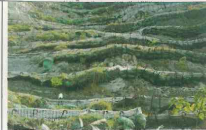
打鋼筋樁編柵(南部泥岩)
