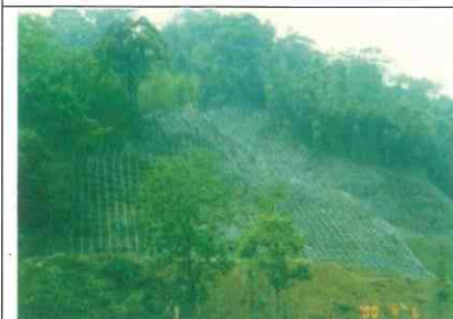
連續混凝土型框工法
