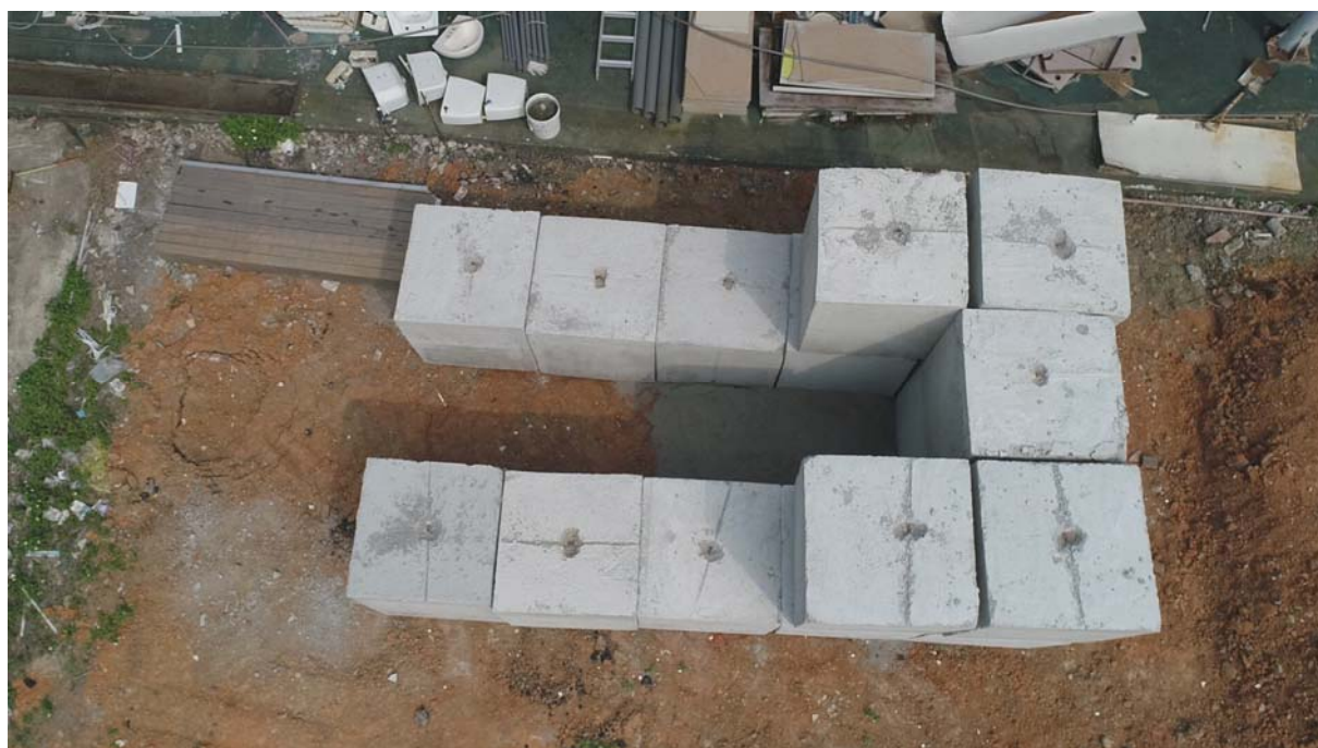
(b)混凝土方塊擺放俯視照片
