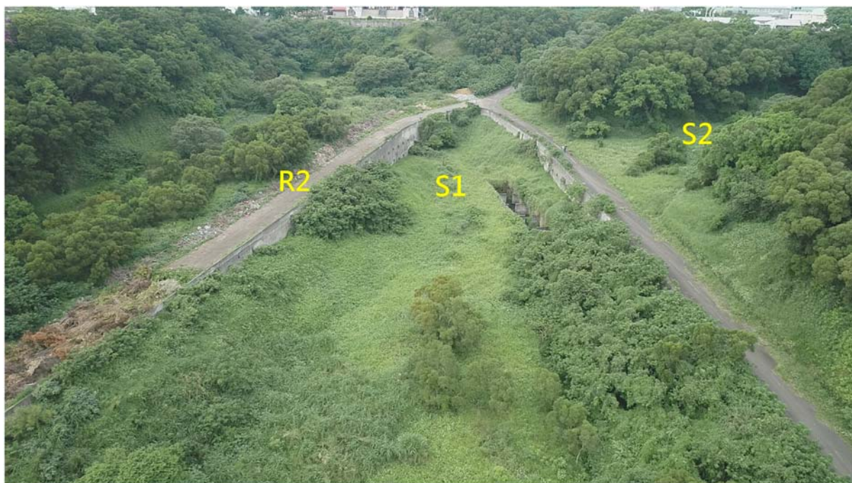
圖 2-9 崩塌地 S1 正面照、S2 側面照與預計配置接收處 R2 處照
