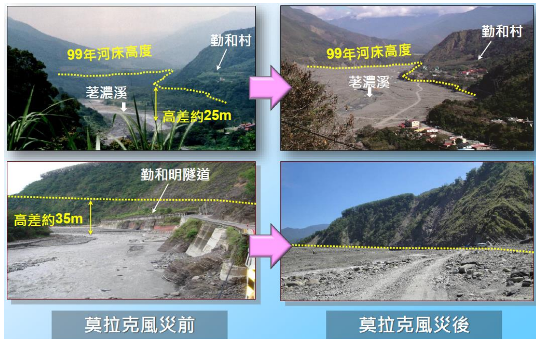
圖 4-12 莫拉克風災抬升荖濃溪河床，重創台 20 線勤和路段之情況。
