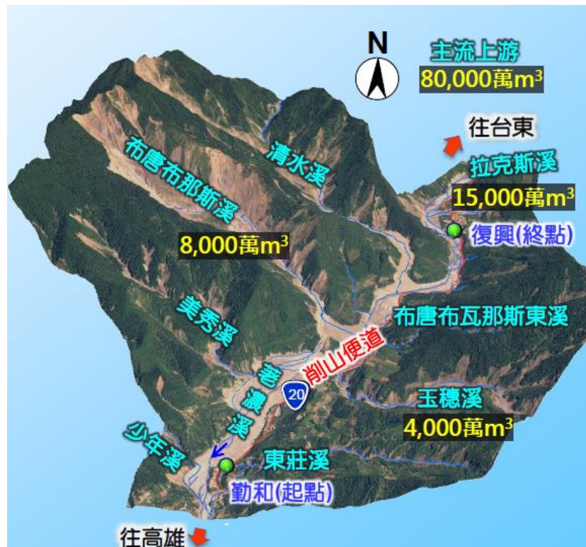
圖 4-14 台 20 線(96.5K~101.5K)勤和至復興路段周邊支流及堆積在支流上游的崩塌量(黃字)。
