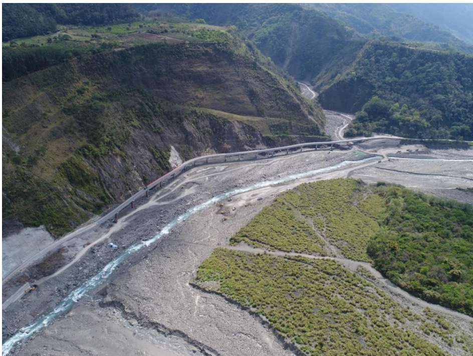
圖 4-8 荖濃溪左岸新建的台 20 線高架橋
