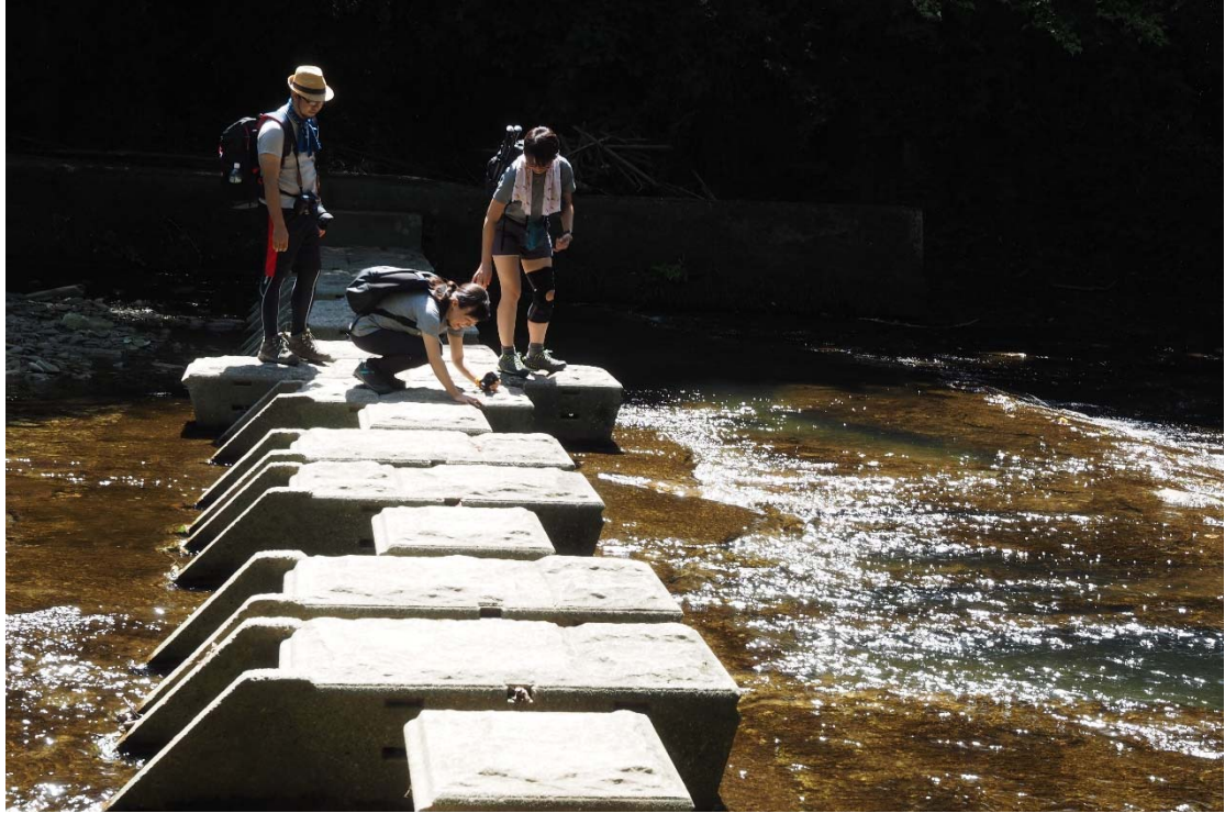
圖 40 日本千葉縣透水式固床工案例二
