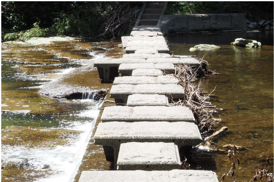
圖 41 日本千葉縣透水式固床工案例三
