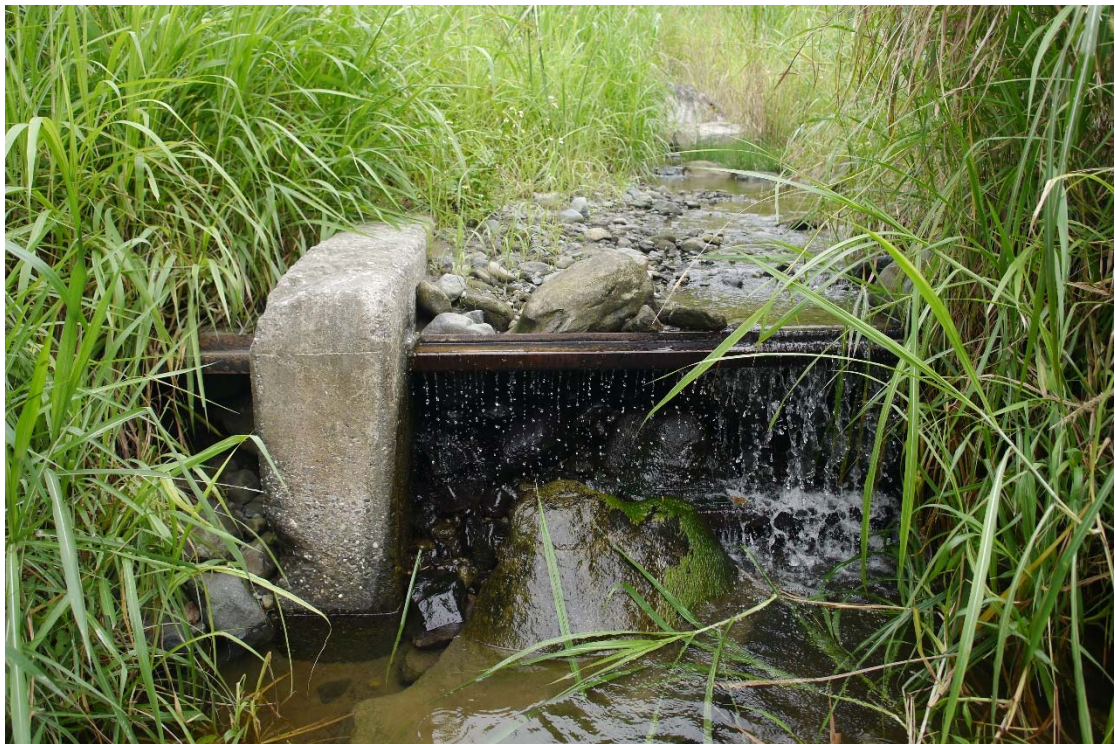
圖 2 格柵透水式固床工後方土砂淤積
