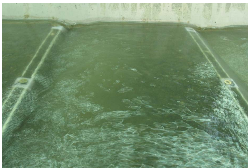
圖 25 水流溢淹漫過透水式 C 型固床工造成投潭的情形
