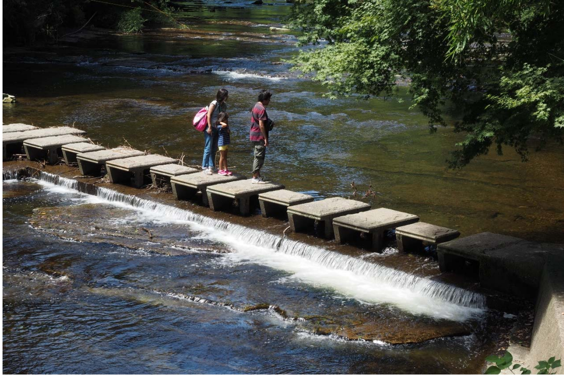
圖 39 日本千葉縣透水式固床工案例一
