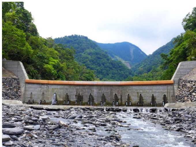
圖 3-18 耐磨鋼板加裝於溢洪口
