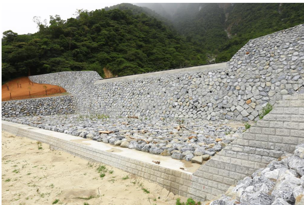
圖 2-3 砌塊石壩面塊石混凝土填心壩
