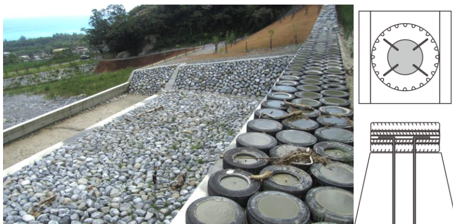
圖 3-18 耐磨鋼板加裝於溢洪口
