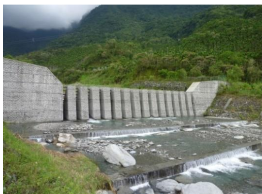
圖 2-4 混凝土鋼構梳子壩示意圖
