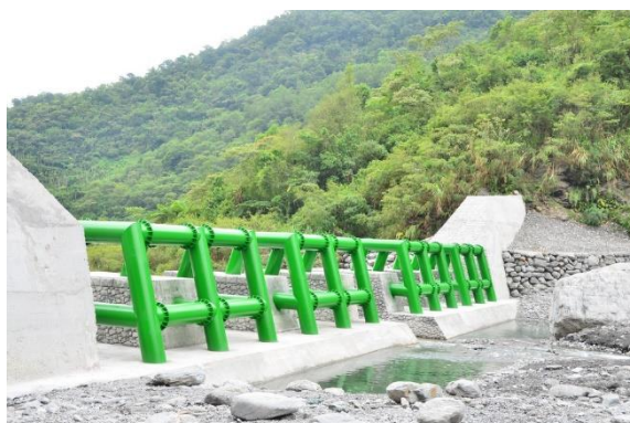
圖 2-4 混凝土鋼構梳子壩示意圖
