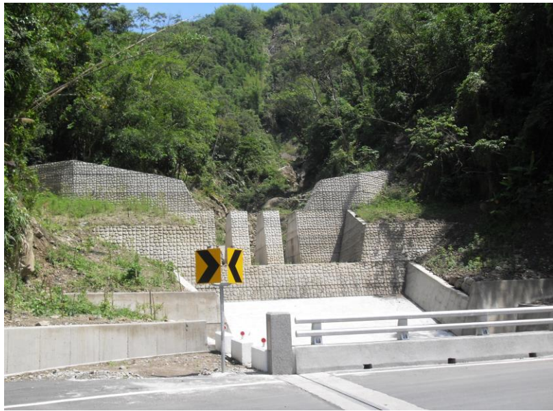
圖 4-12 山美 2 鄰野溪災害復建工程之梳子壩
