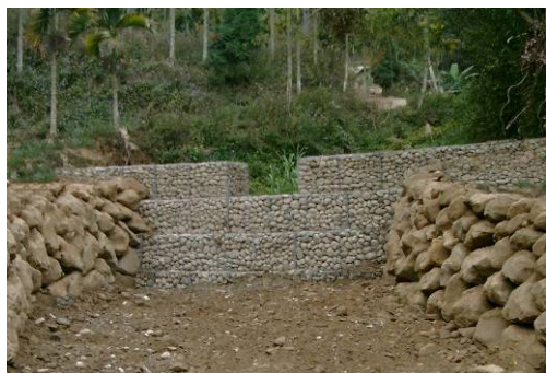
照片 4-59 箱籠壩與砌石護坡
