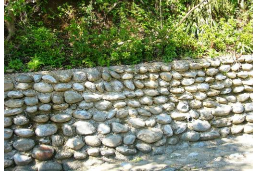
照片 4-54 漿砌石護岸
