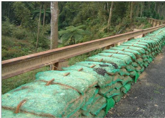
照片 4-22 土壤袋應用於臨時性邊坡保護目的 (南投縣魚池鄉)
