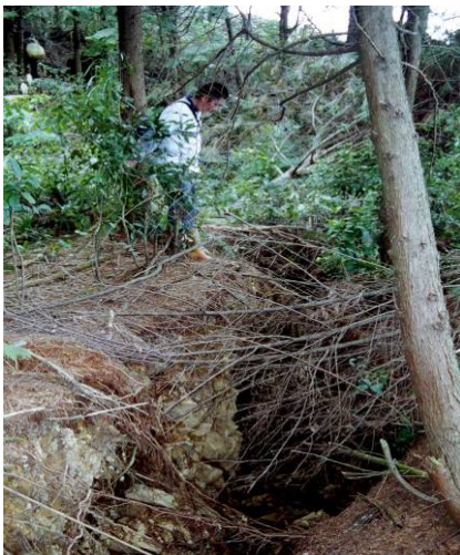
照片 4-3 坡頂裂縫勘查
