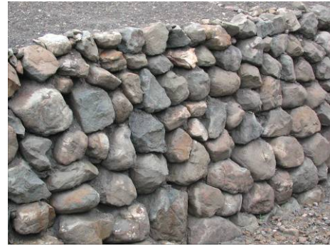
照片 4-52 乾砌石護岸(台中頭汴坑溪)
