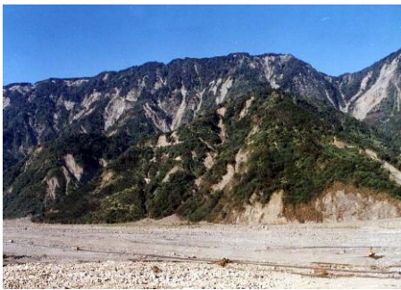
照片 3-4 南投縣水里鄉郡坑對岸稜線之崩塌地
