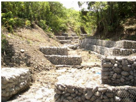
照片 3-6 蝕溝控制-箱型石籠(北坑溪)
