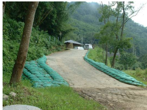
照片 4-27 土袋銀行示範工程(好農村工區)
