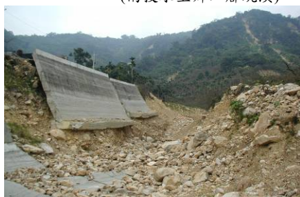
照片 3-2 桃芝颱風引發土石流後河道侵蝕情形
