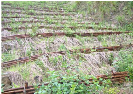
照片 4-7 打樁編柵後覆蓋稻草蓆
