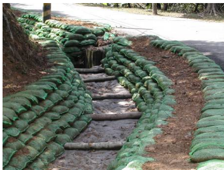
照片 4-5 簡易排水設施
