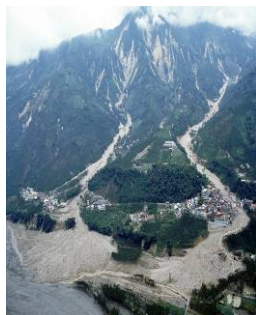
照片 3-1 土石流災害照片 (南投水里鄉二廊坑溪)
