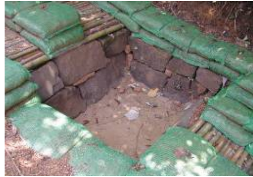
照片 4-41 砌塊石集水井
