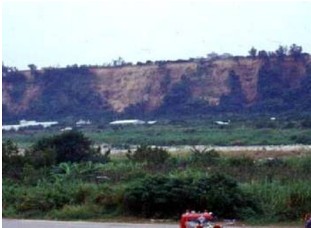
照片 1-1 台中新社鄉台地邊緣崩塌地
