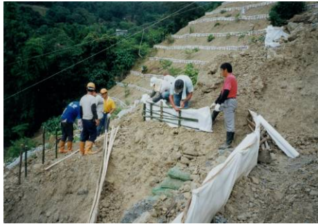
照片 4-6 打樁編柵施工中
