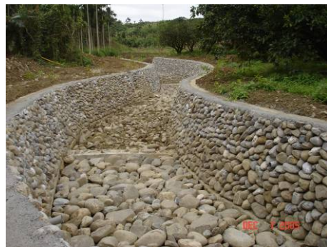
照片 4-45 砌石溝(鶴岡太平頂)
