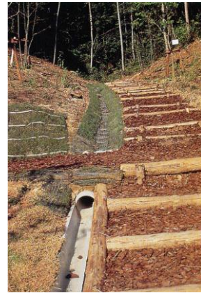
照片 4-48 涵管應用於縱向排水示意圖(上為草溝；中為涵管；下為 U 型預鑄溝)
