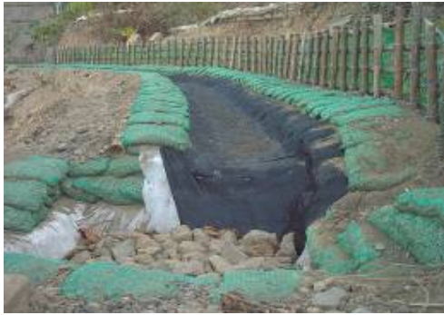
照片 4-40 砌塊石集水井
