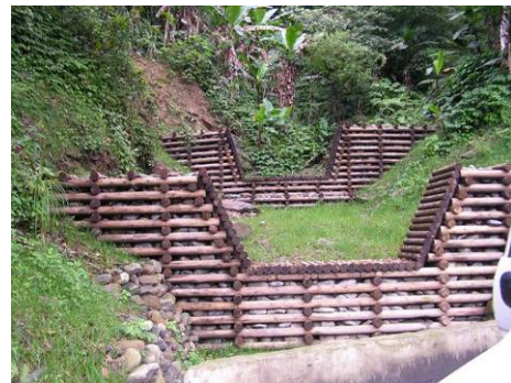
照片 3-7 原木節制壩(宜專一線林道)
