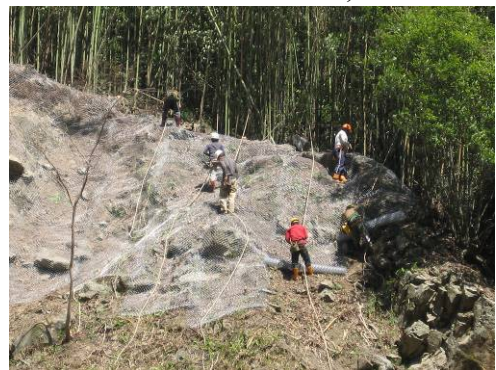
照片 4-17 施工中---鋪網
