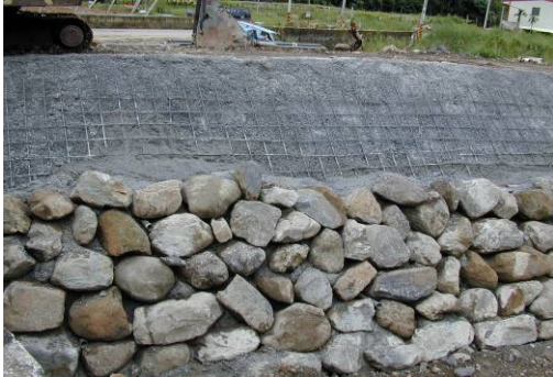
照片 4-53 混凝土砌石護岸(施工中)
