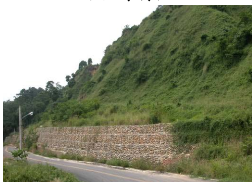
照片 4-60 道路坡腳箱籠擋土牆施工例
