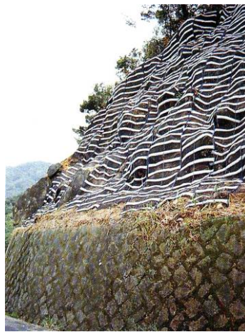
照片 4-21 坡面掛網肥束帶施工
