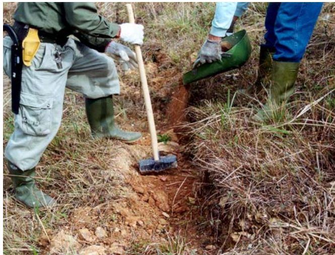
照片 4-4 坡頂裂縫填補情形
