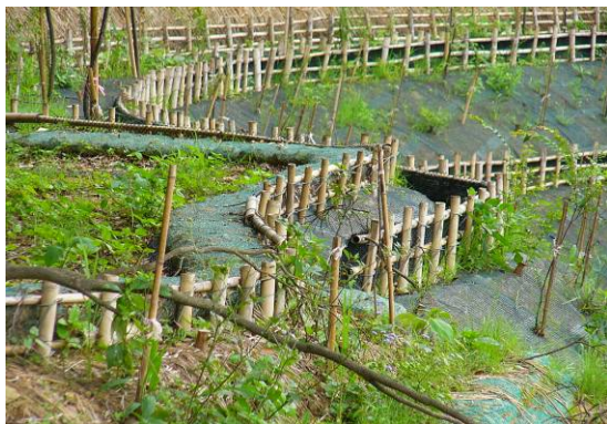
照片 4-12 打竹樁編塑格網柵
