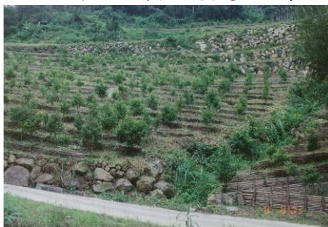
照片 4-9 打樁編柵植生成果(一年後)
