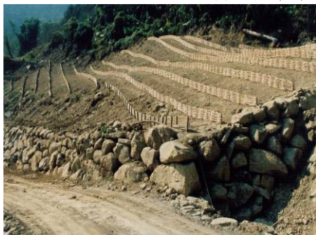
照片 4-8 打樁編柵完工一景
