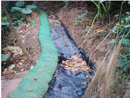
照片 4-36 坡頂客土袋截水溝
