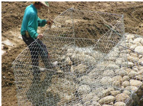
照片 4-57 箱籠施作情形
