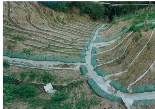
照片 4-23 應用土壤袋施作坡面截排水 (南投縣水里鄉)
