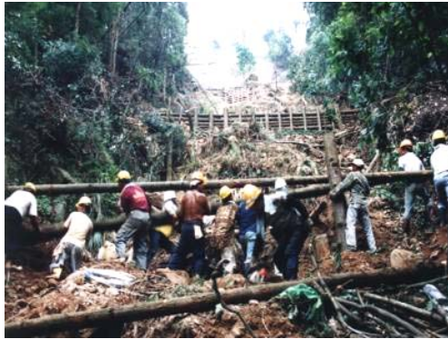
照片 4-14 原木樁檔土柵施工情形
