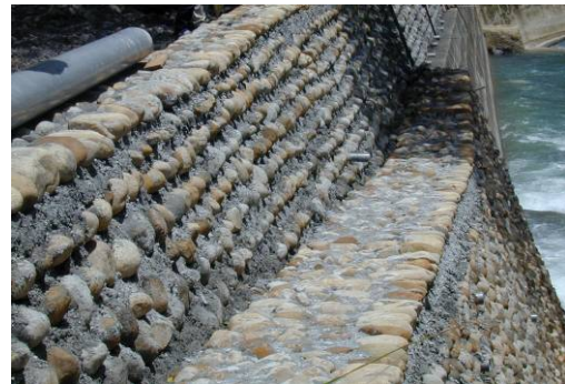
照片 4-56 混凝土席墊砌石護岸(台北三峡蚵仔溪)
