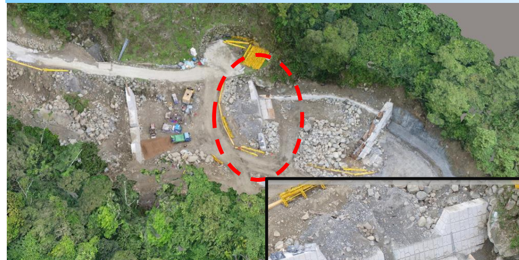
華興野溪及崩塌地整治工程 2018/4/25模型拍攝成果
