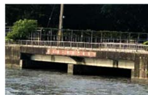
圖 4-12：濁水溪二號水門 進水口
