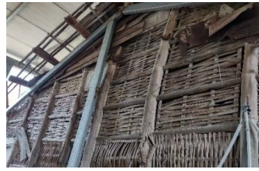
圖 5-2：竹管厝建築外壁
