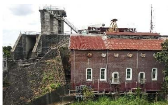
圖 4-1：濁水發電所外部環境
