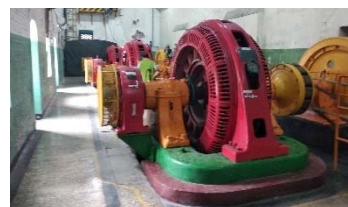
圖 4-3：日本奧村電機製三相發電機組
