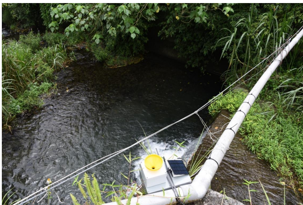
圖 4-33 小礁溪儀器安裝
