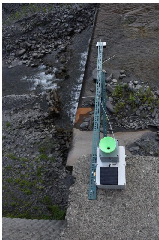
圖 4-23 碼崙儀器安裝近照
