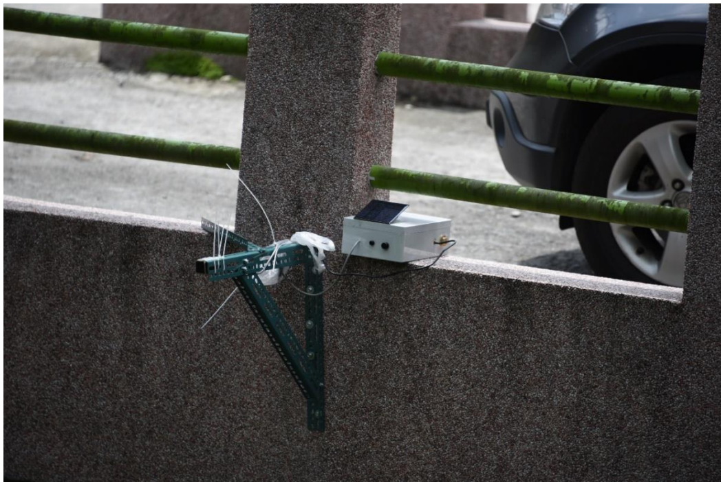
圖 4-27 崩山湖儀器安裝近照(上游側)
