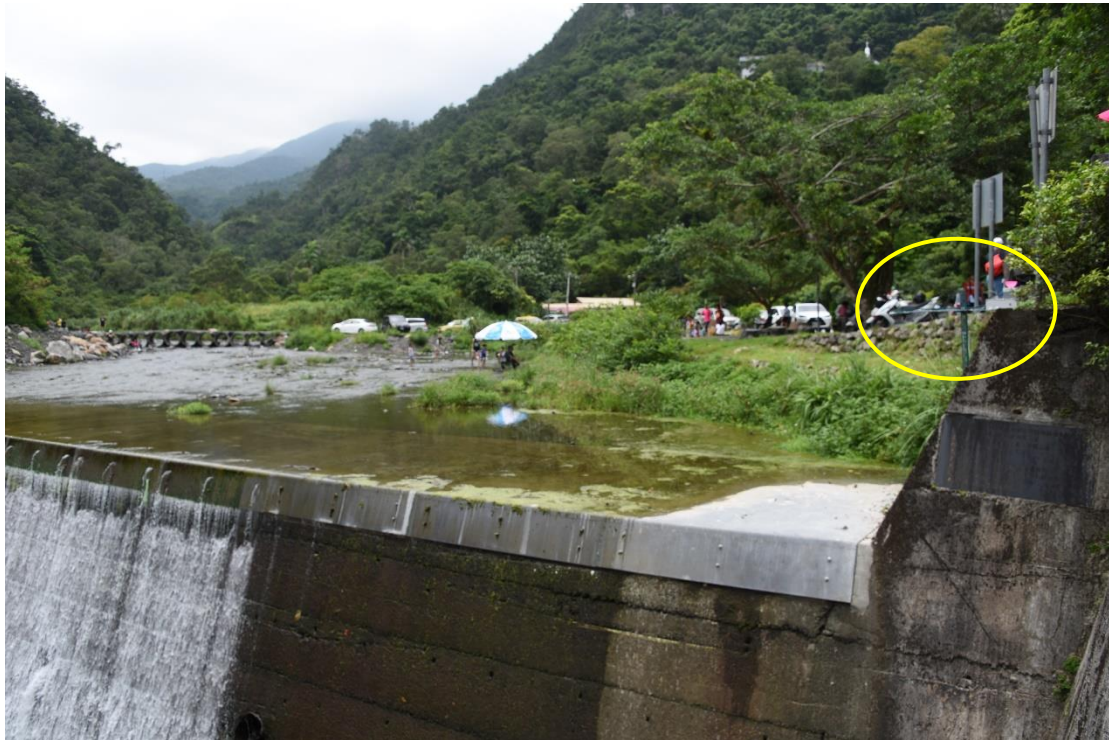
圖 4-6 得子口溪防砂壩儀器安裝遠照(二)
