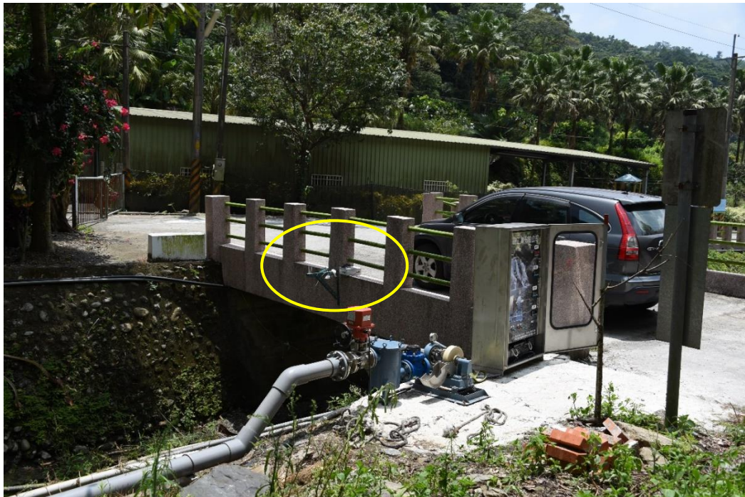
圖 4-29 崩山湖儀器安裝遠照(上游側)
