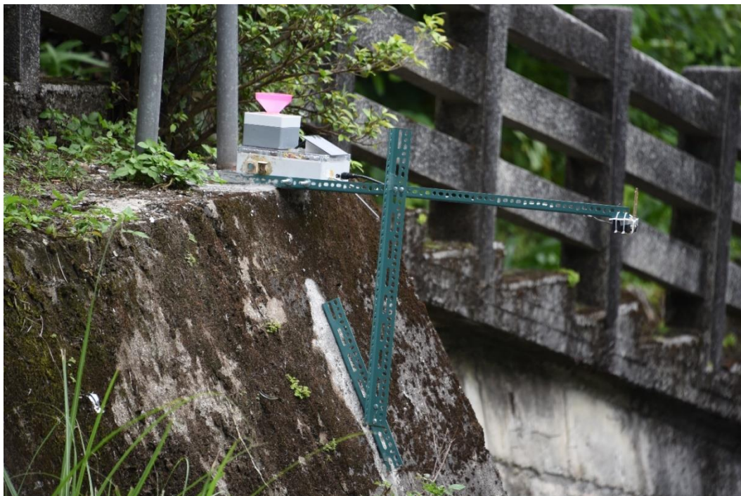
圖 4-39 得子口溪防砂壩儀器安裝遠照(一)
