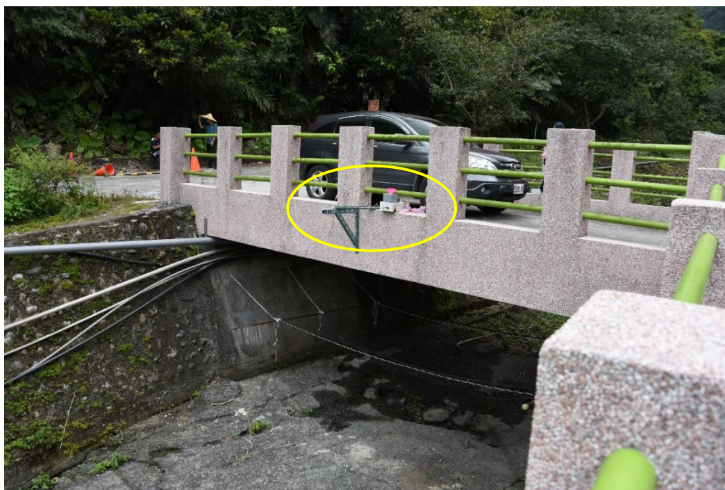
圖 4-30 崩山湖儀器安裝遠照(下游側)
