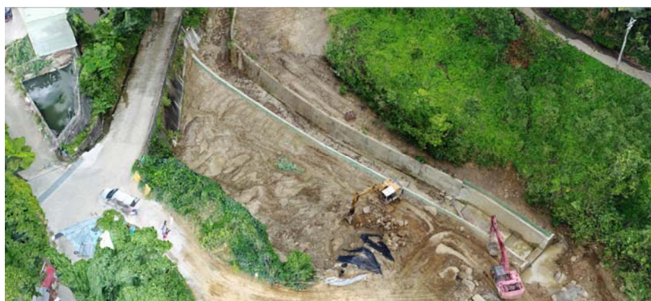
(b) 107.6.26 完工現場樣貌
