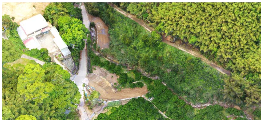
圖 2-24 建置工區真實現地模型技術成果(新店大東勢溪上游支流整治工程-施工前)
