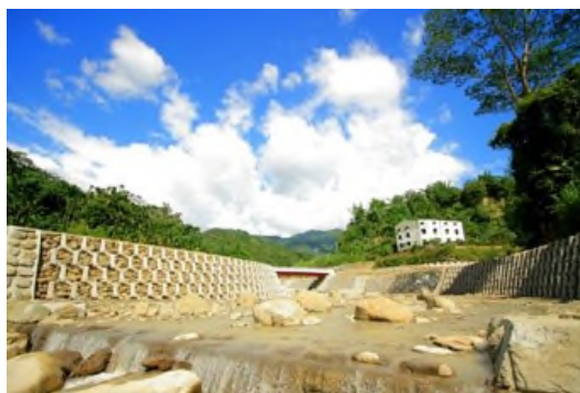
圖 3- 14 觀石溪安定橋段整治工程(水保局南投分局)
