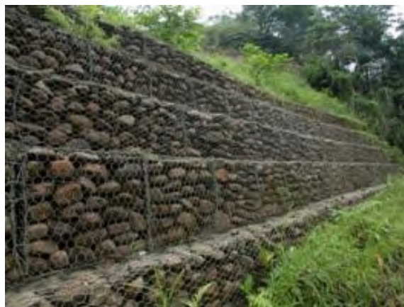
圖 3- 12 后番子坑溪整治工程(水土保持局)
