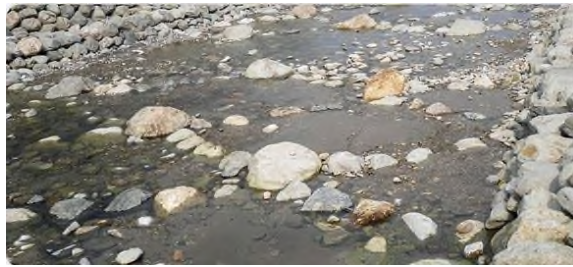
圖 3-6 白鮑溪土石災害防治二期工程(水土保持局)
