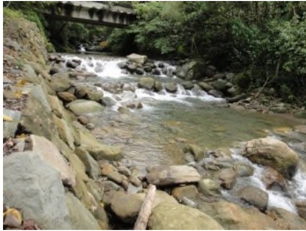
圖 3- 11 喜龍橋及本生橋下游野溪治理工程(水土保持局)
