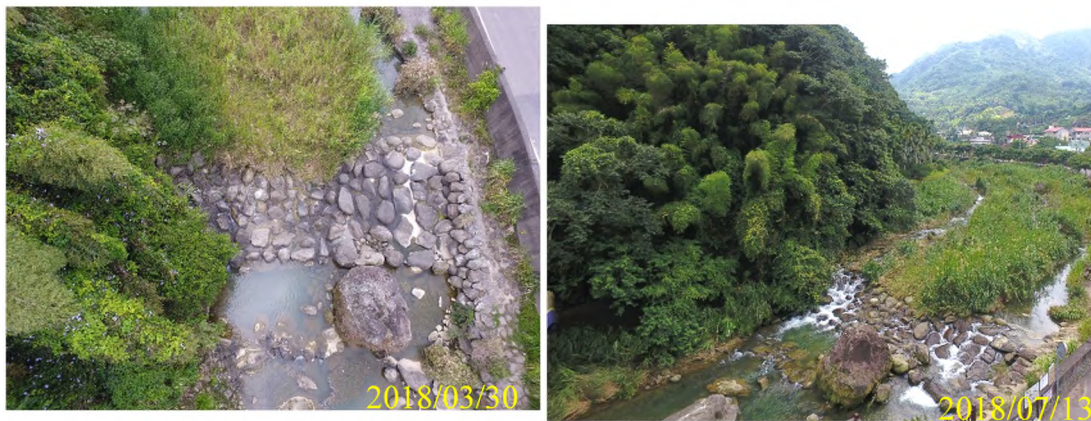
圖 5- 4 抽藤坑溪中和橋下游現況圖(本團隊拍攝)
