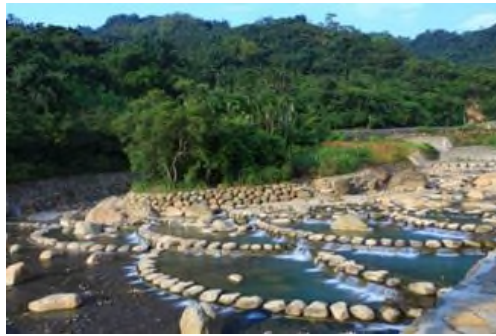
圖 3-8 粗坑吊橋上游野溪整治二期工程(水土保持局)
