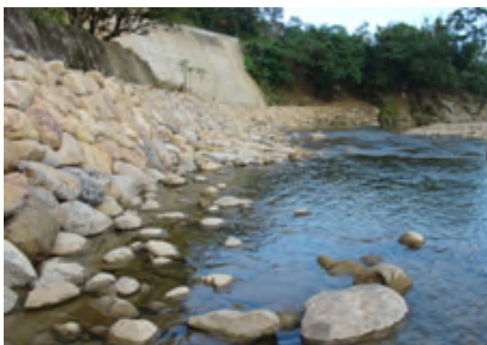
圖 3- 13 雙溪河平林一號橋上游之乾砌石護岸(水土保持局)
