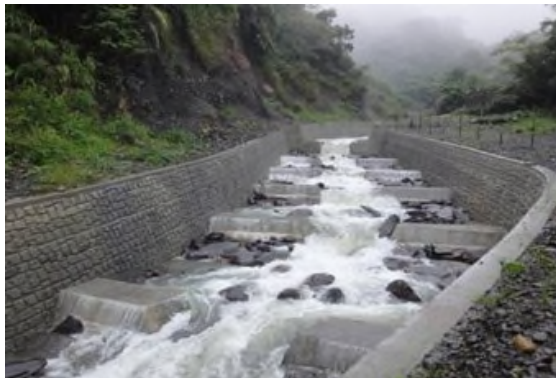
圖 3-9 小礁溪上游坡地保育工程(水土保持局)
