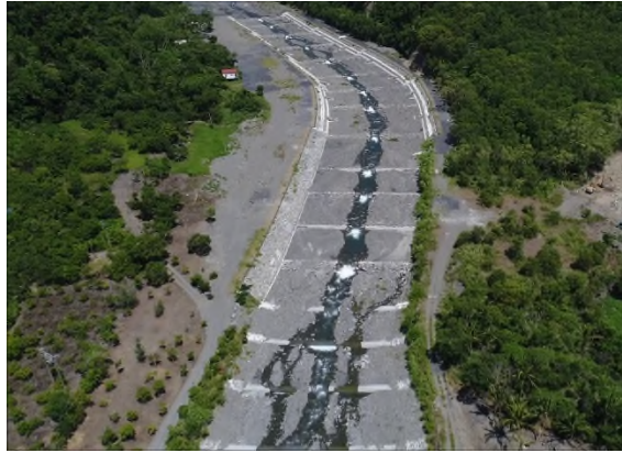
圖 3- 10 台坂溪野溪治理二期工程(水土保持局)
