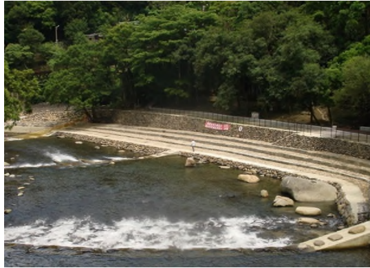
圖 3-15 小烏來風景特定區宇內溪戲水區及河岸景觀改善工程 (桃園市政府)
