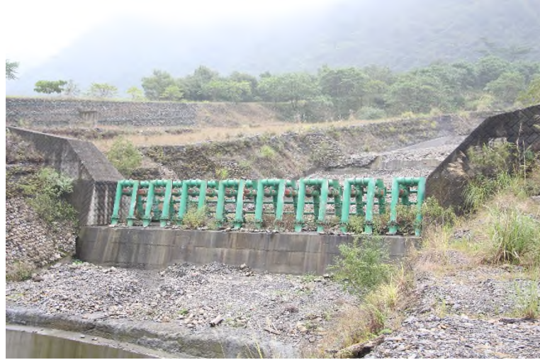
圖 5- 13 南投蘭島溪鋼管壩(本團隊拍攝)
