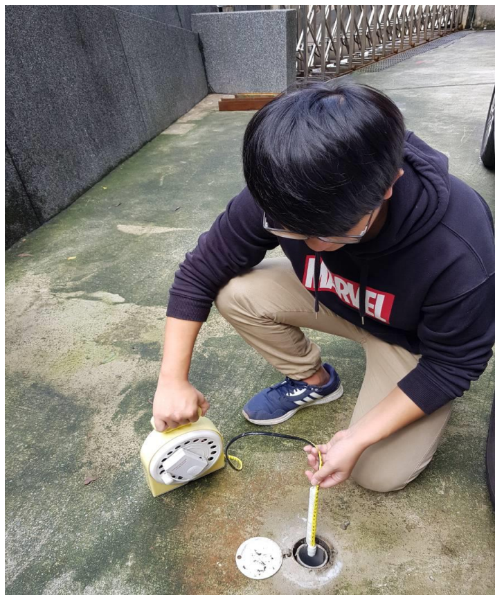
圖 3-4.5 地下水位監測井與簡易地下水位量測設備
