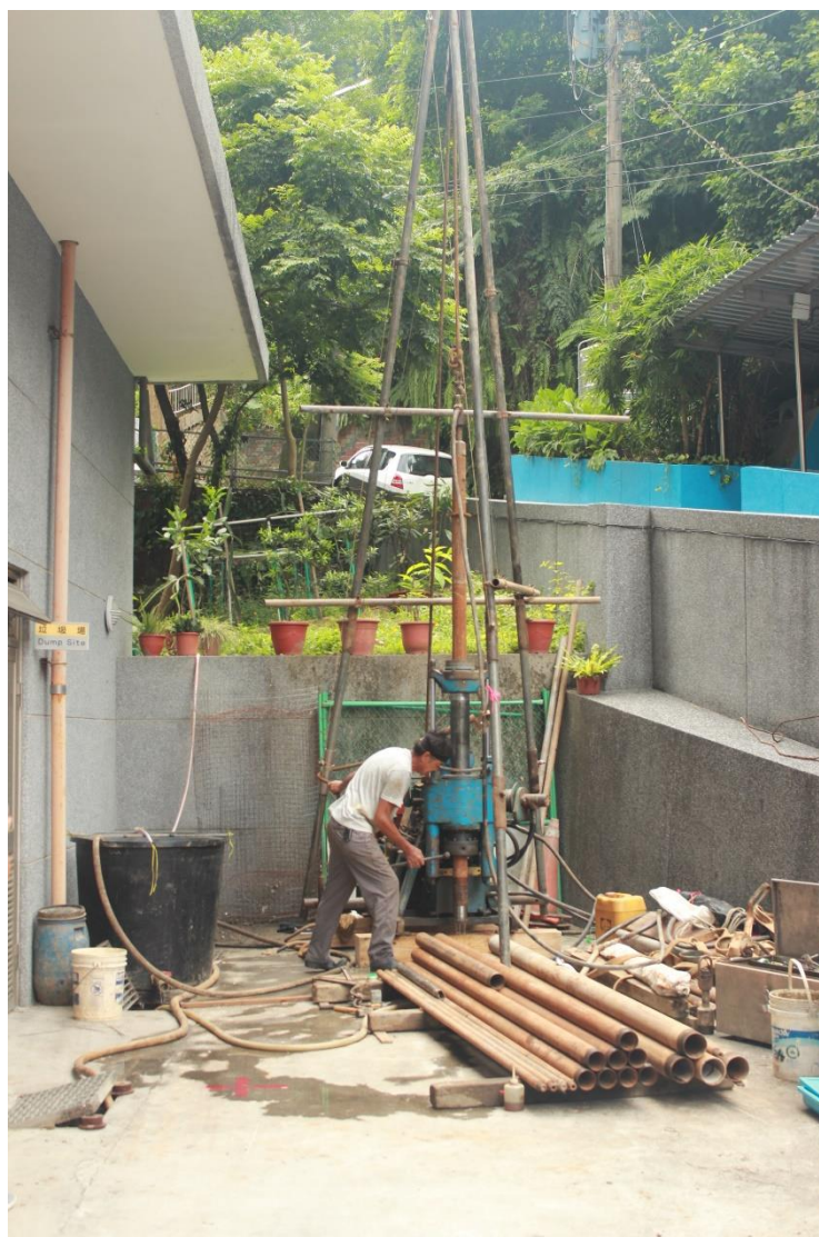
圖2-4.1 地層鑽探施工圖
