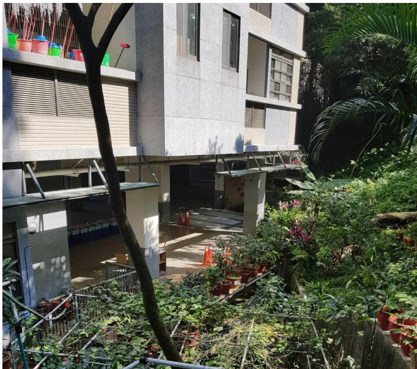
圖 3-2.4 地層鑽探選址(校園後方坡地側景)
