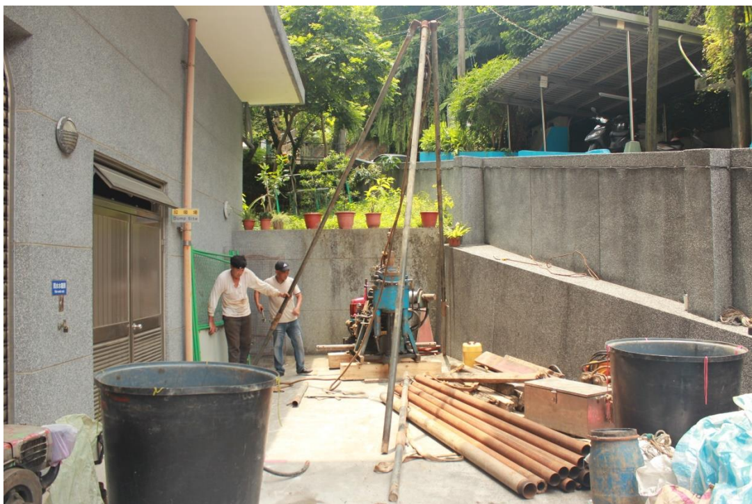
圖 3-4.1 機具架設與確定鑽探孔位地點
