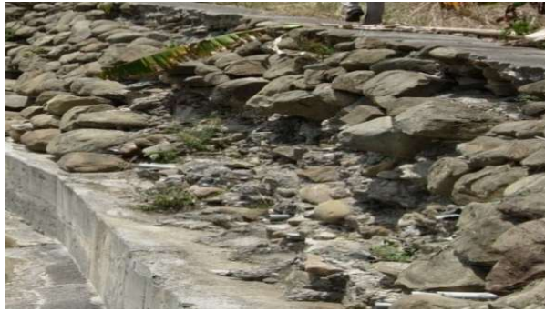
圖 4-4 設施產生剝落形態
