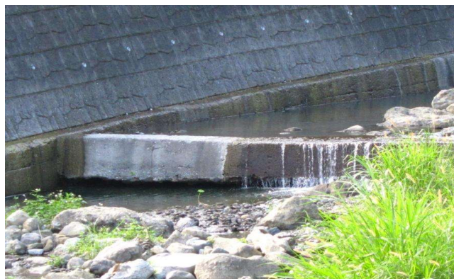
圖 4-6 設施產生淘空破壞形態
