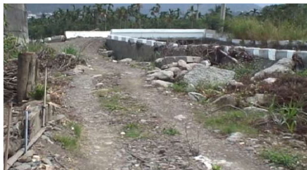
圖 4-1 周圍材料流失樣態
