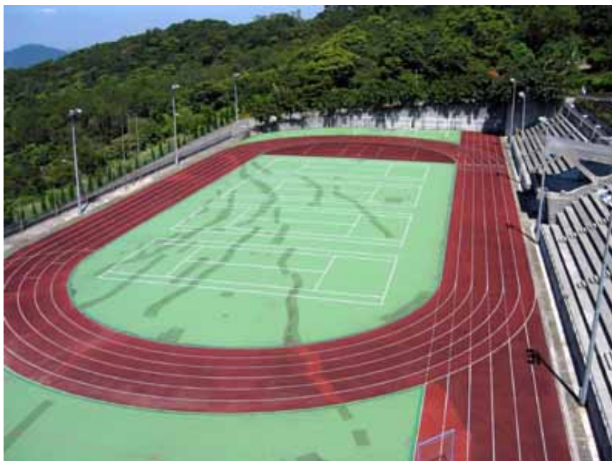
圖 2-6 華梵大學校園西北部份可能的滑動塊體之地表破裂
