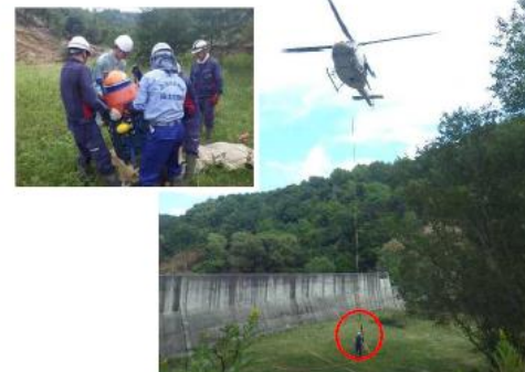
上流側 水位計(水位観測ブイ)設置準備状況
