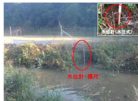
下流側 水位計(水圧式)、標尺設置完了状況
