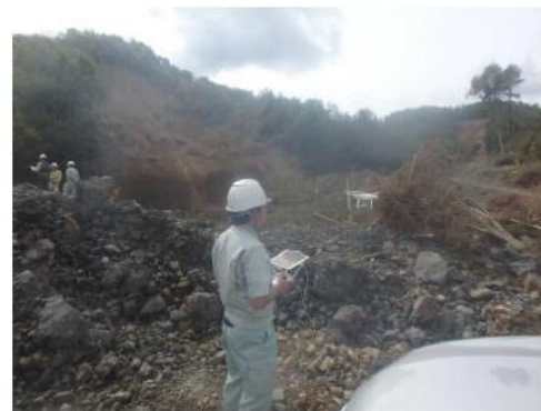
UAVによる河道閉塞調査(9/25)
