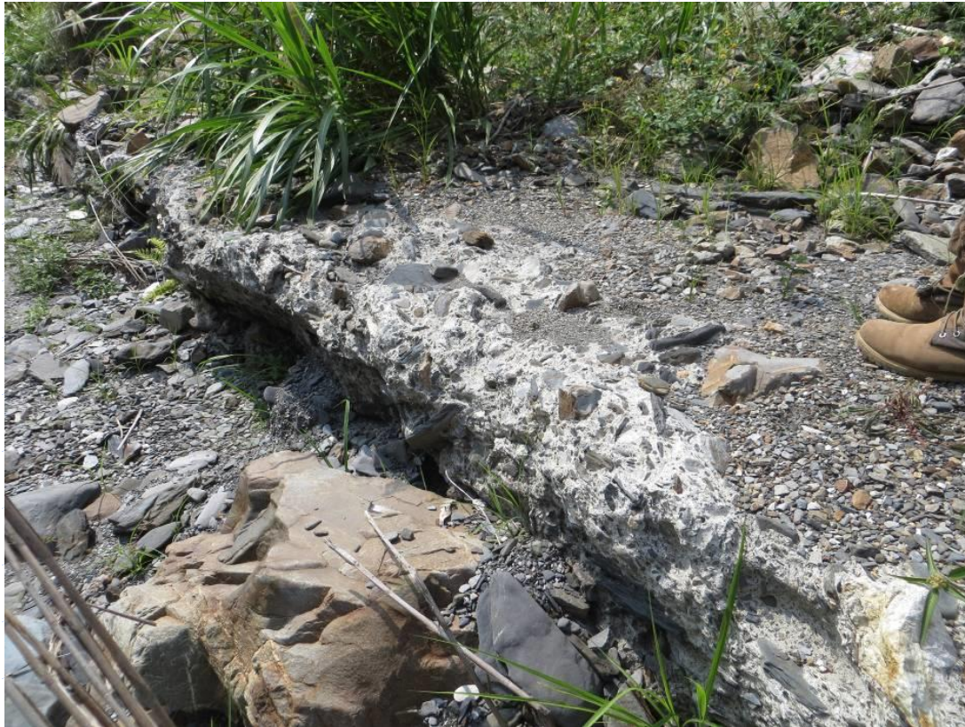
合望溪構造物之非破壞檢測試驗場址
