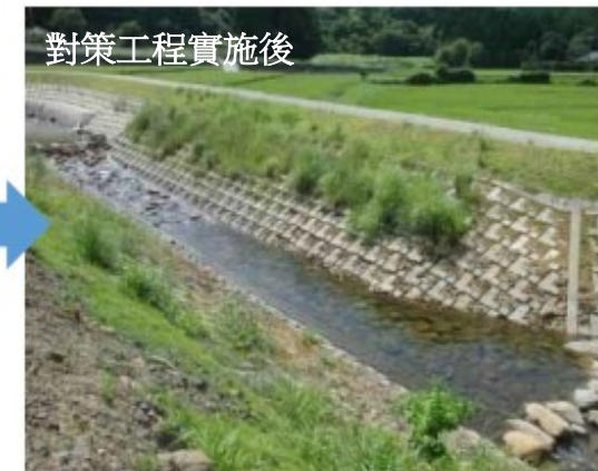
對策工程實施後 使用和整治前類似的河床材料，實施回填
