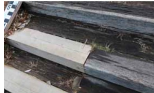
部分完成修補的木製階梯 木製階梯須定期修補。 公部門應與民眾合作進行相關修繕工作。
