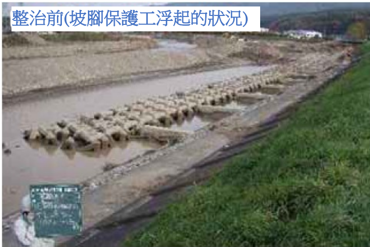
整治後(坡腳保護工設在較深的位置)
