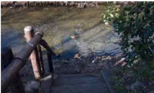
坡度陡峭（44.5 度），難以上下行走的階梯 往流心方向設置，可能比較好用。
