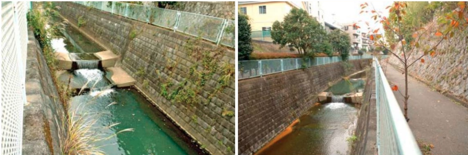
因為河川直線化而設置大量固床工的都市河川
