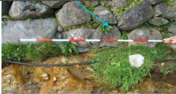
塊石疊砌護岸的隙縫長出繁茂的植物
