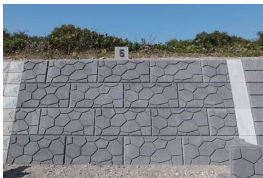
預鑄混凝土塊護岸鋪設（正面）改良前
