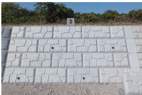
預鑄混凝土塊護岸鋪設（正面）改良前
