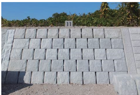
預鑄混凝土塊護岸鋪設（正面）
