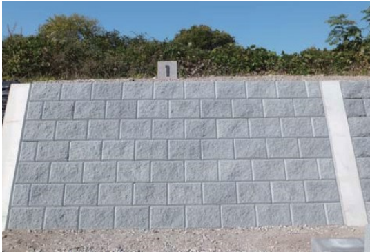
預鑄混凝土塊護岸鋪設（正面）改良前
