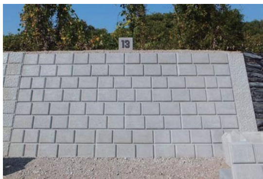
預鑄混凝土塊護岸鋪設（正面）
