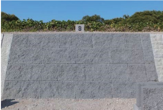
預鑄混凝土塊護岸鋪設 (正面)
