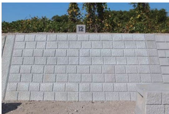
預鑄混凝土塊護岸鋪設（正面）
