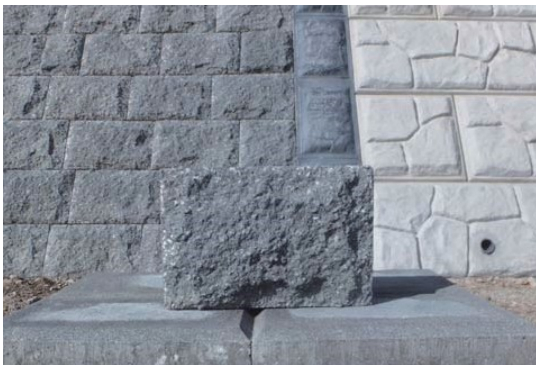
預鑄混凝土塊護岸單體（正面）改良後
