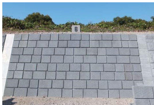
預鑄混凝土塊護岸鋪設（正面）改良後
