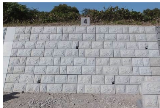
預鑄混凝土塊護岸鋪設（正面）改良後
