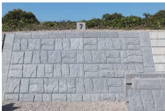
預鑄混凝土塊護岸鋪設（正面）
