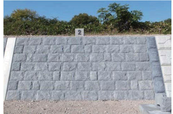
預鑄混凝土塊護岸鋪設（正面）改良後
