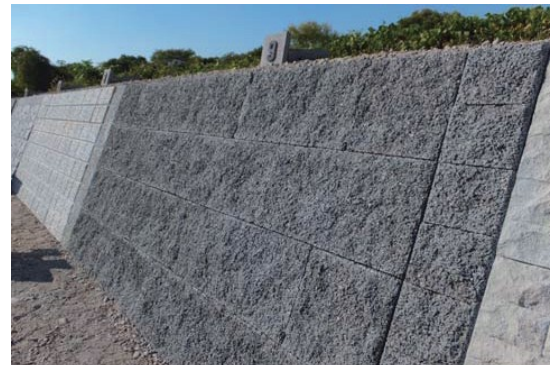
護岸端牆 (牆) 預鑄混凝土塊
