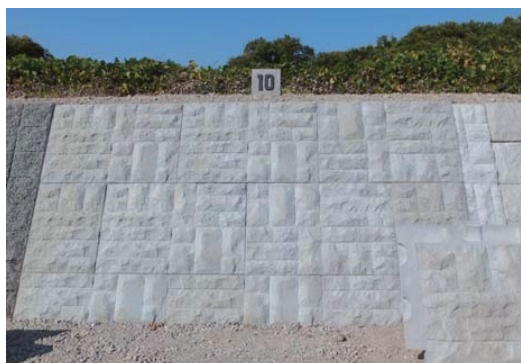
預鑄混凝土塊護岸鋪設（正面）
