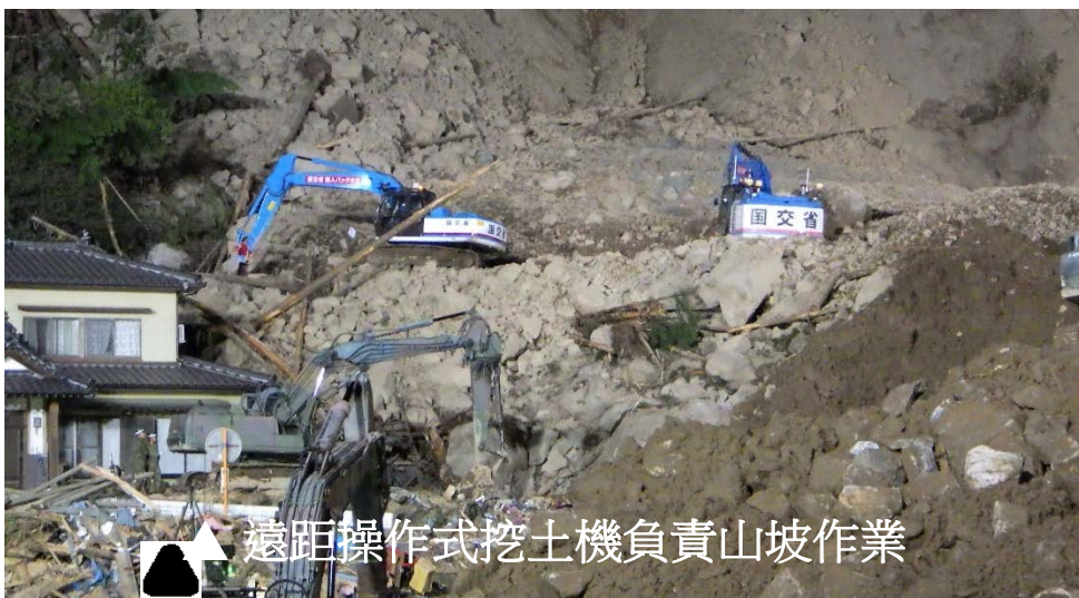
▲快速架設無人化施工所需的移動式遠距操作式挖土機
