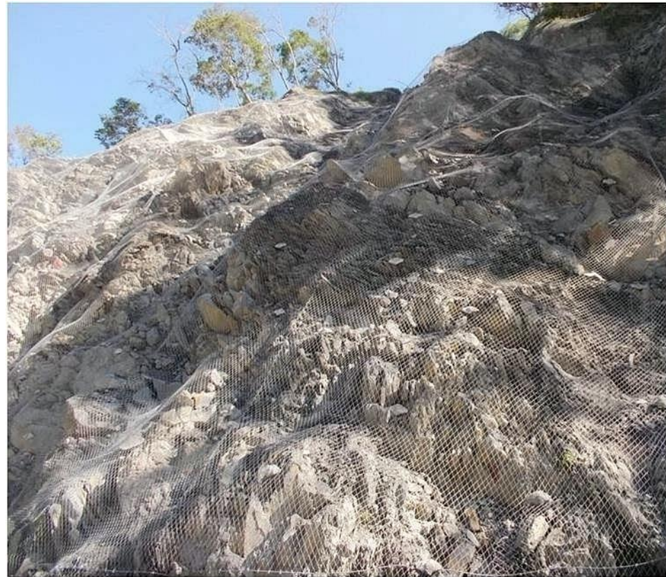
掛網岩栓護坡
